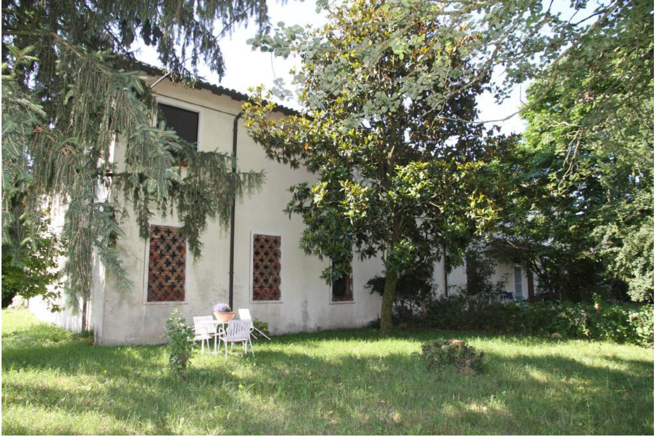
Foto n° 34 - Terreno sul retro fabbricato
