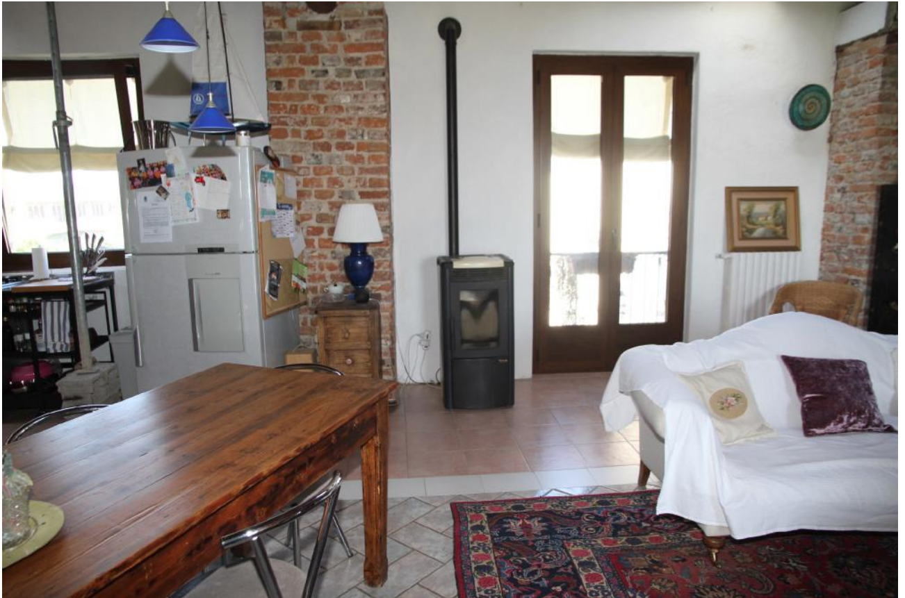
Foto n° 9 - Piano primo open space - caldaia a pellet
