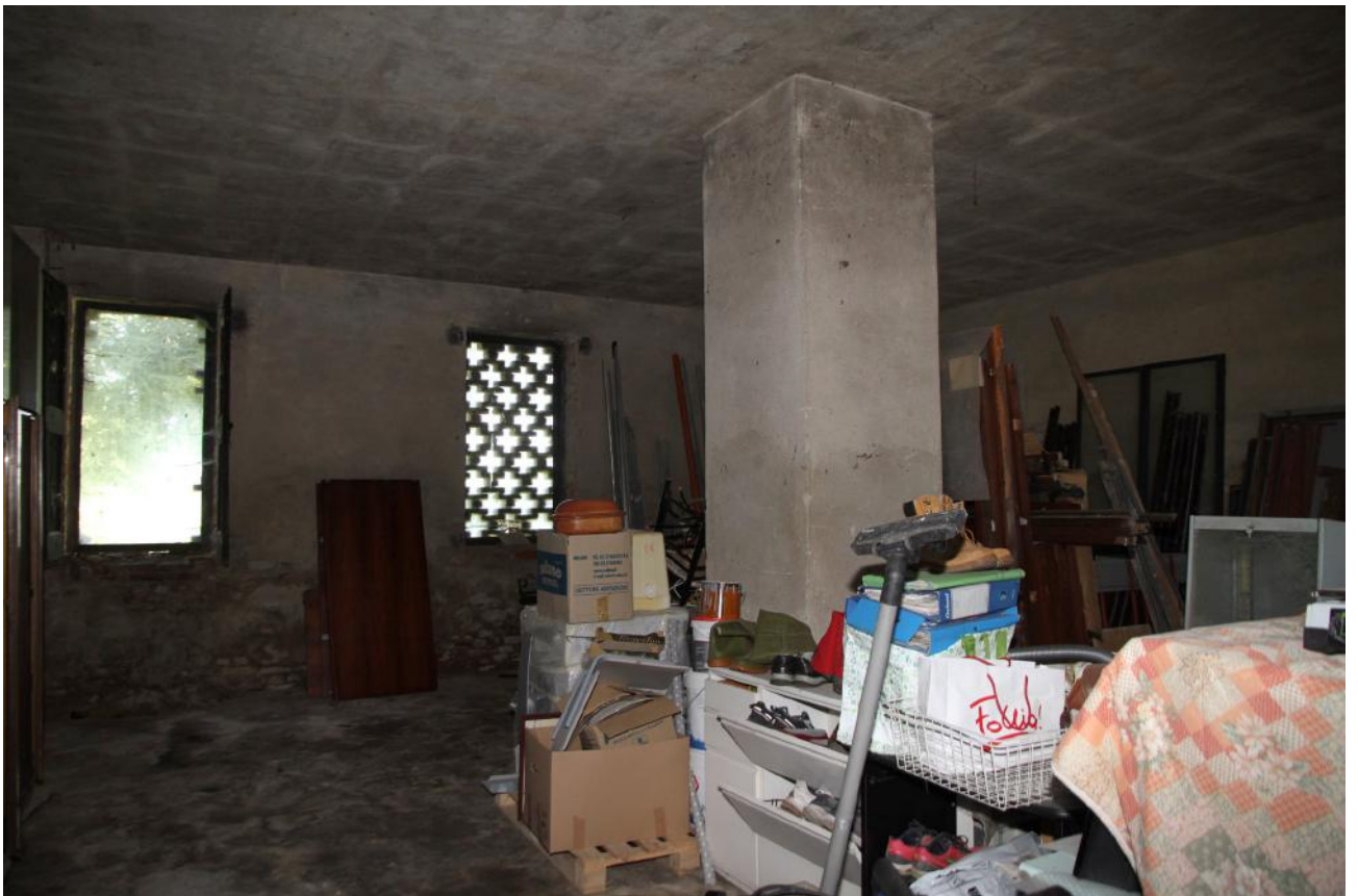
Foto n° 25 - Piano terreno - attuale destinazione sgombero
