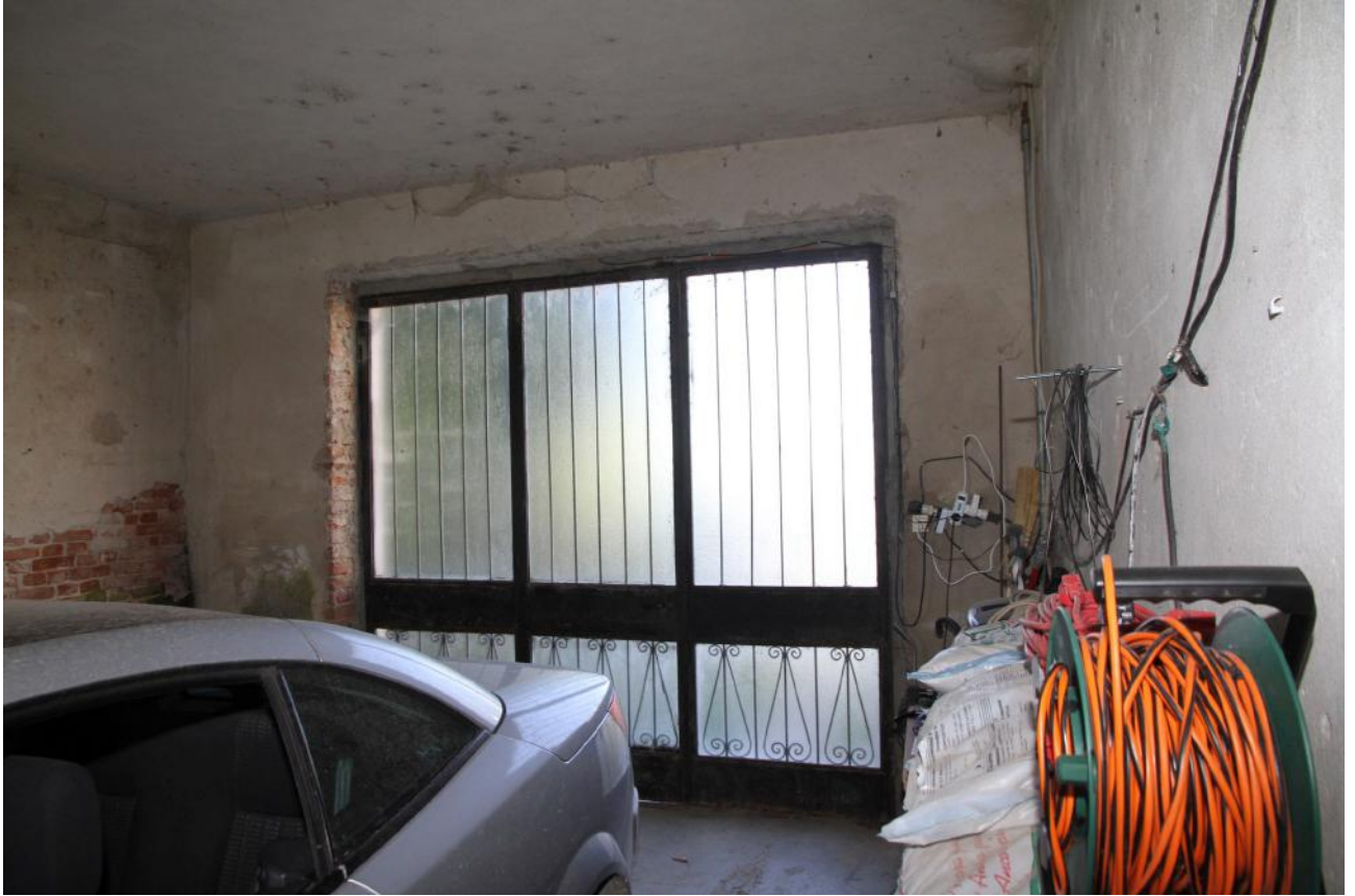
Foto n° 30 - Piano terreno - attuale destinazione box
