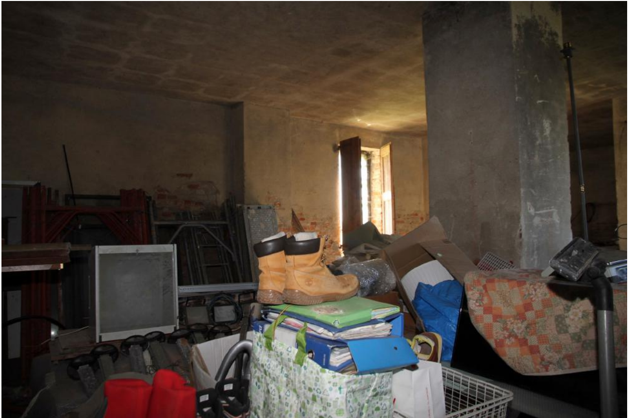
Foto n° 26 - Piano terreno - attuale destinazione sgombero
