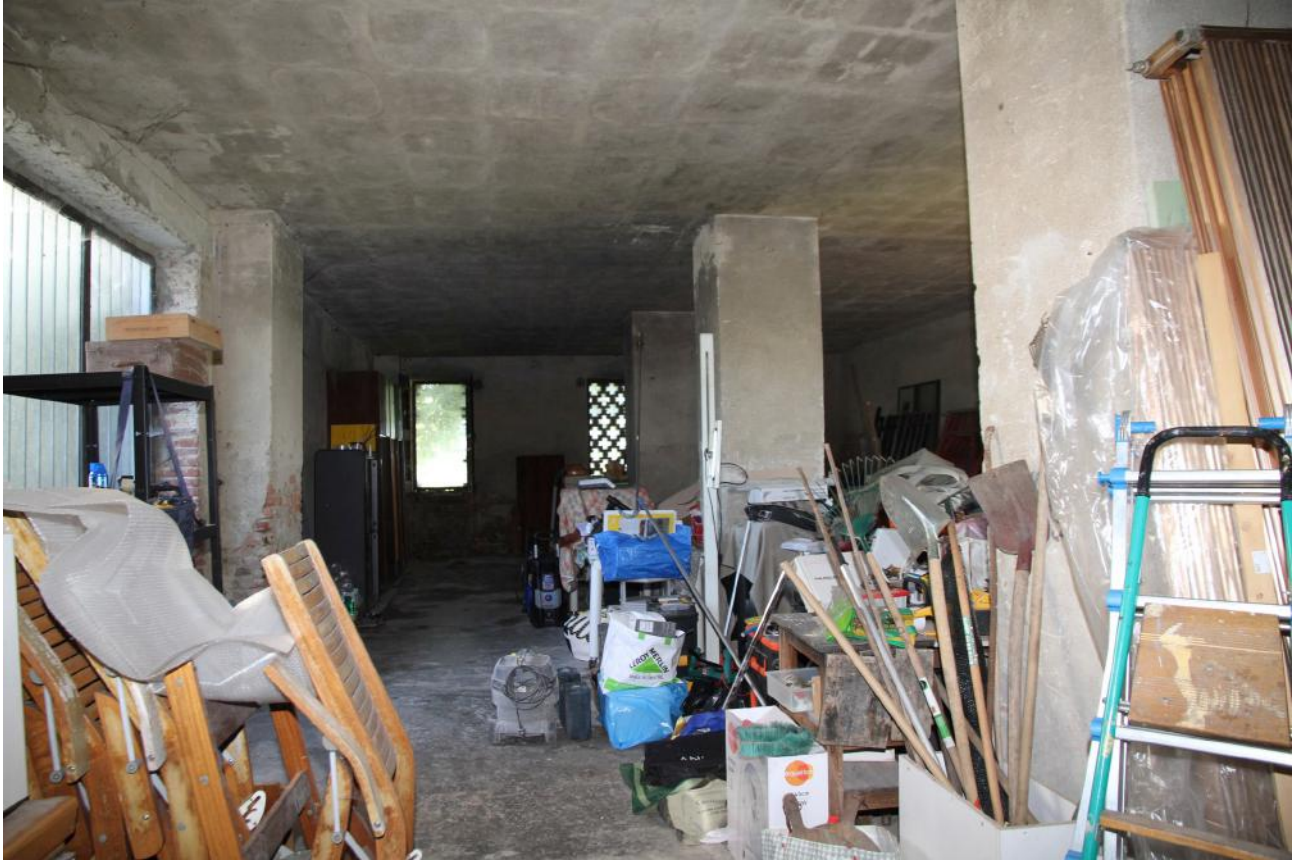
Foto n° 23 - Piano terreno - attuale destinazione sgombero
