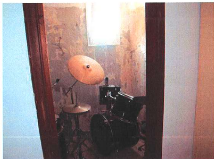
Foto n.36 – w.c. da ultimare
