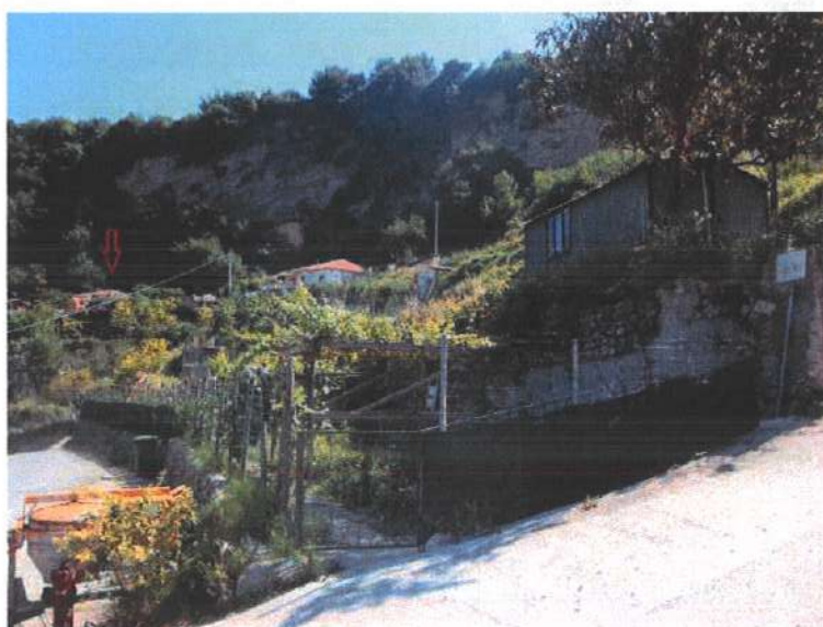
Foto n.2 – via Due Camini – inizio strada d'accesso e manufatto non regolare
