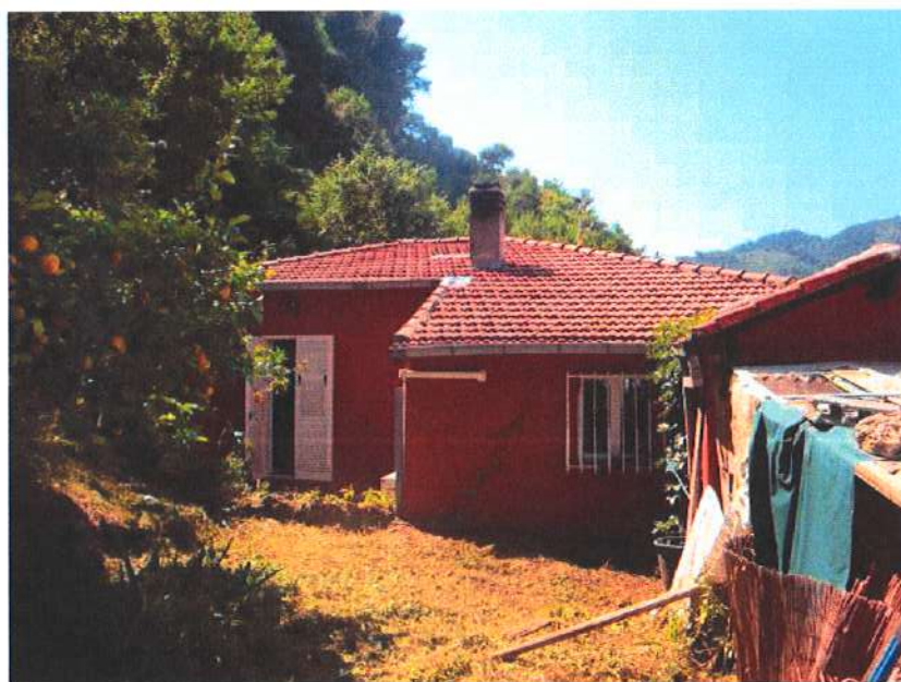
Foto n.16 – abitazione con a fianco un manufatto NON regolare
