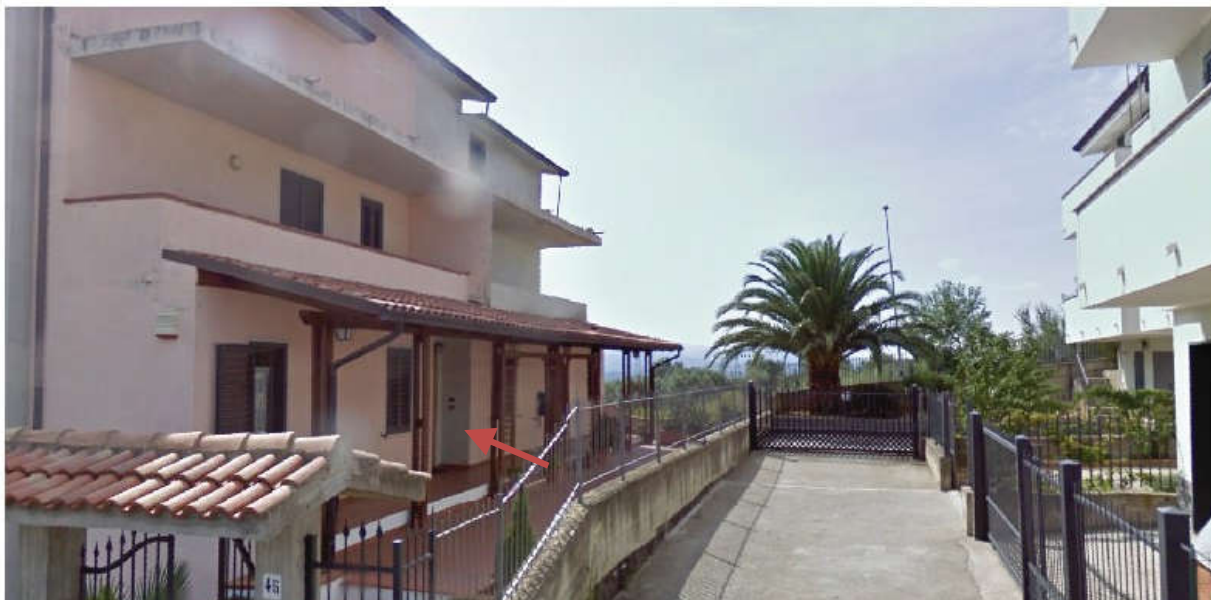
Foto n. 2 Ingresso Piano Terra
