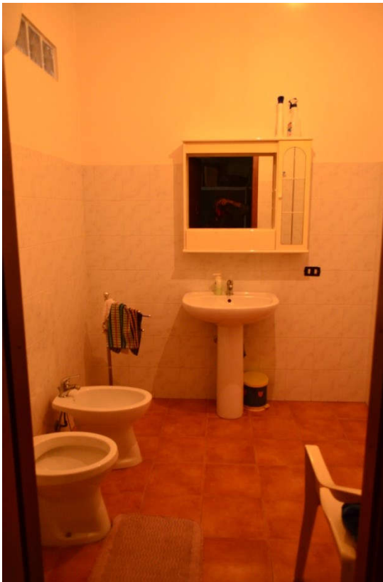
Foto n.28 WC zona deposito
