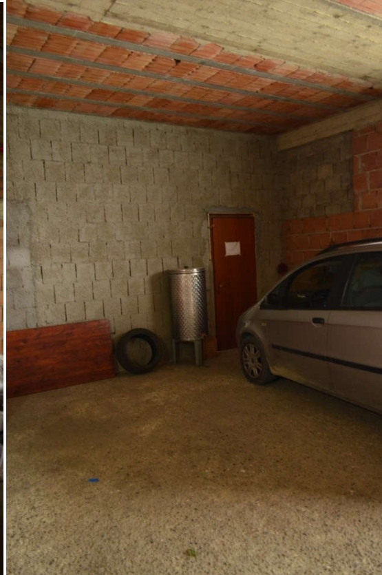
garage con parete divisoria con porta accesso al deposito
