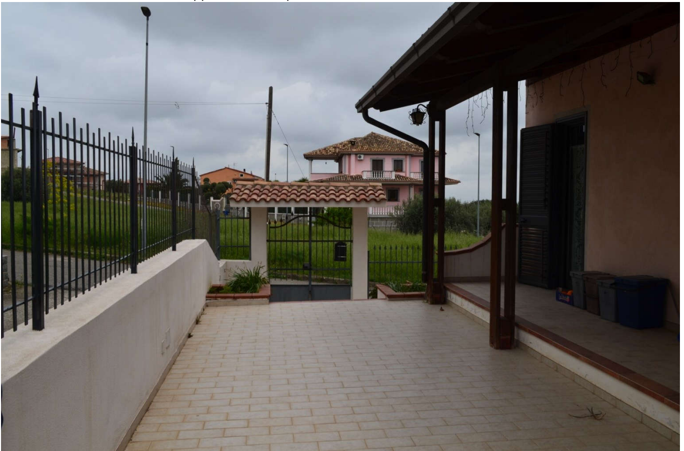
Foto n. 3. Interno della corte 1 appartenente al piano terra
