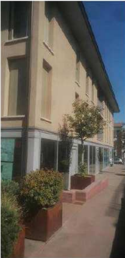
prospetto lato strada
