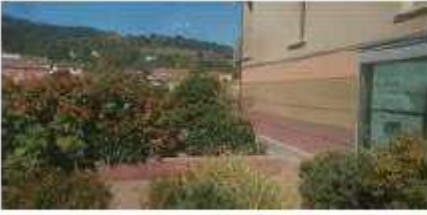
prospetto lato fiume
