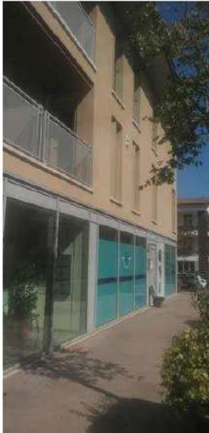
Facciata lato viale Vittoria
