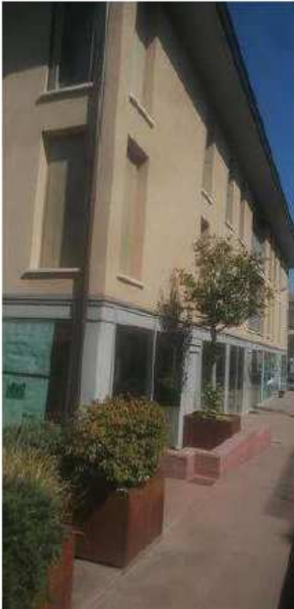
Facciata lato viale Vittoria
