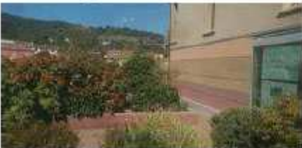
prospetto lato fiume
