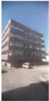
Facciata prospiciente la strada Comunale di accesso
