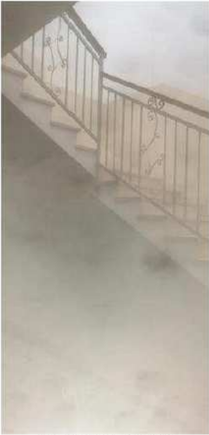
Vano scala interno di accesso ai piani
