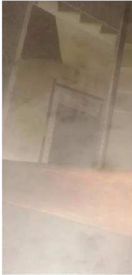
Vano scala interno di accesso ai piani
