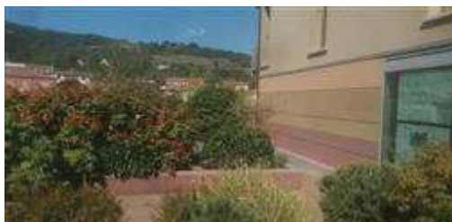
prospetto lato fiume
