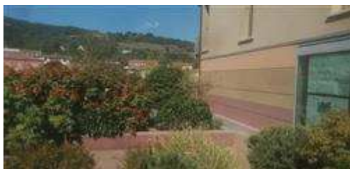
prospetto lato fiume
