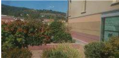
prospetto lato fiume
