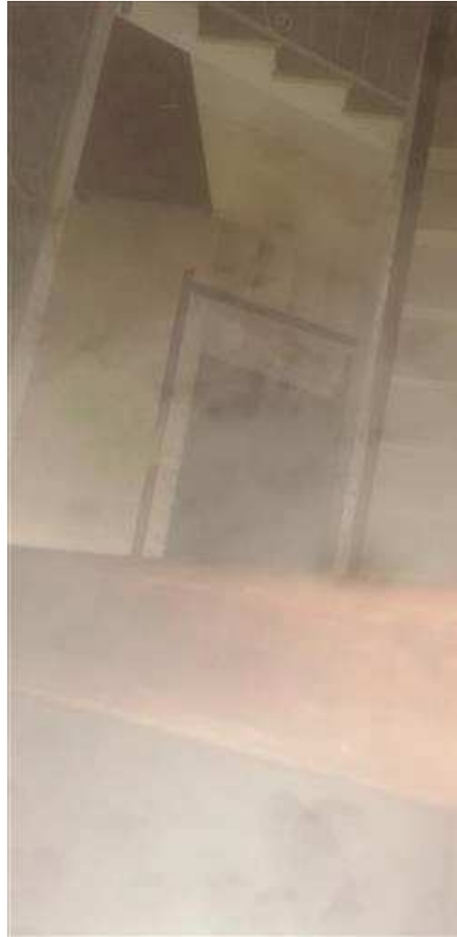
Vano scala interno di accesso ai piani
