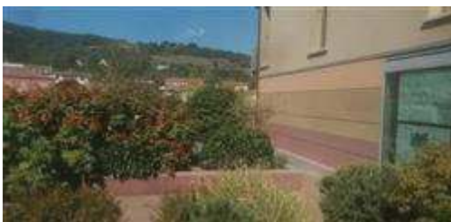
prospetto lato fiume
