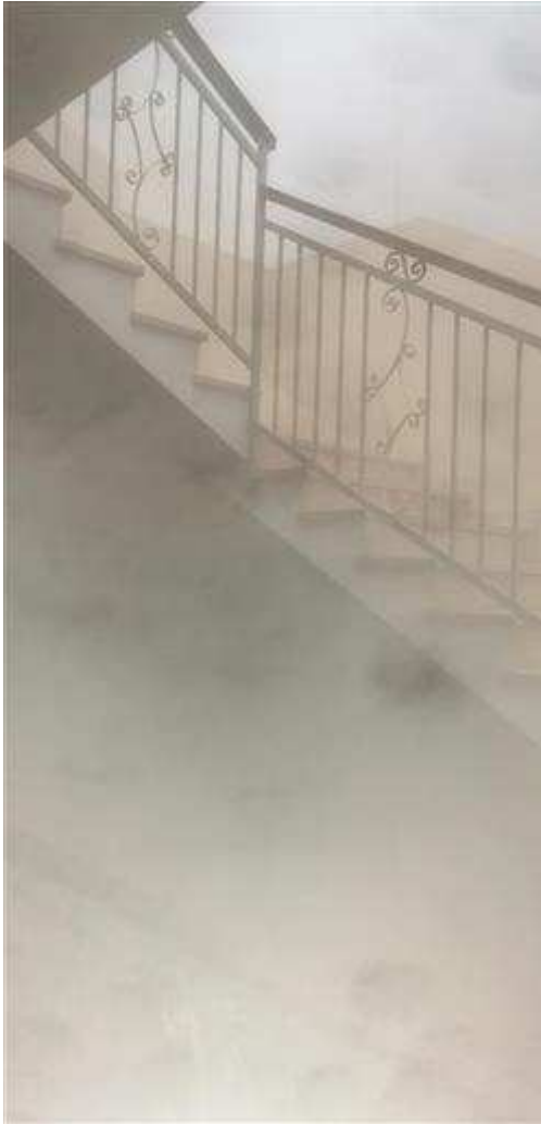
Vano scala interno di accesso ai piani
