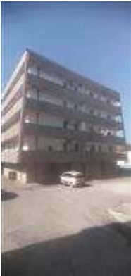
Facciata prospiciente la strada Comunale di accesso
