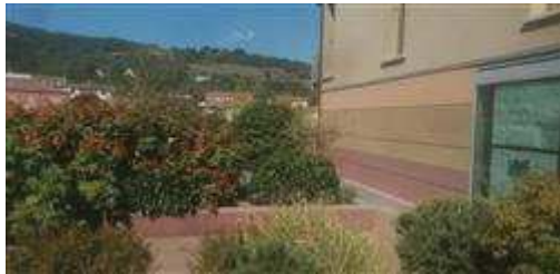
prospetto lato fiume
