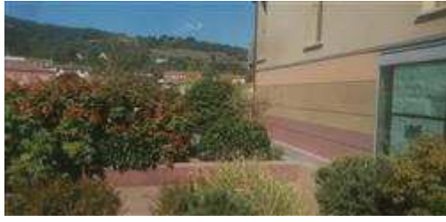
prospetto lato fiume
