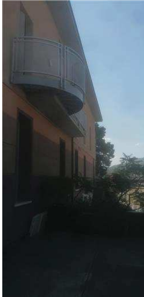
Prospetto lato fiume
