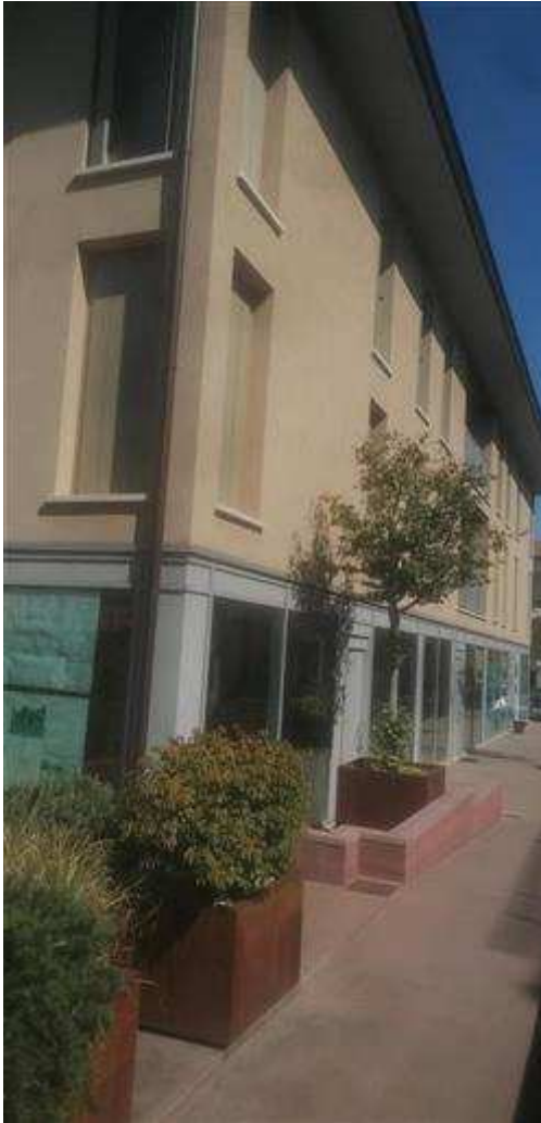
Facciata lato viale Vittoria
