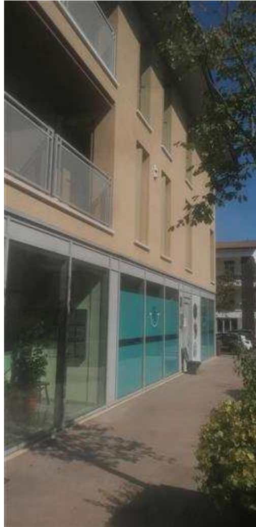
Facciata lato viale Vittoria
