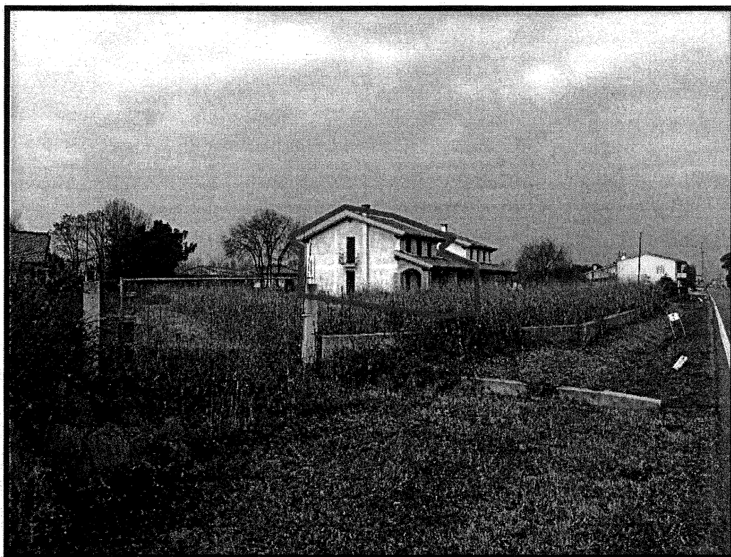
Foto n. 2: Vista bifamiliare ai piano terra e primo, prospetti Nord-Est e Sud-Est
