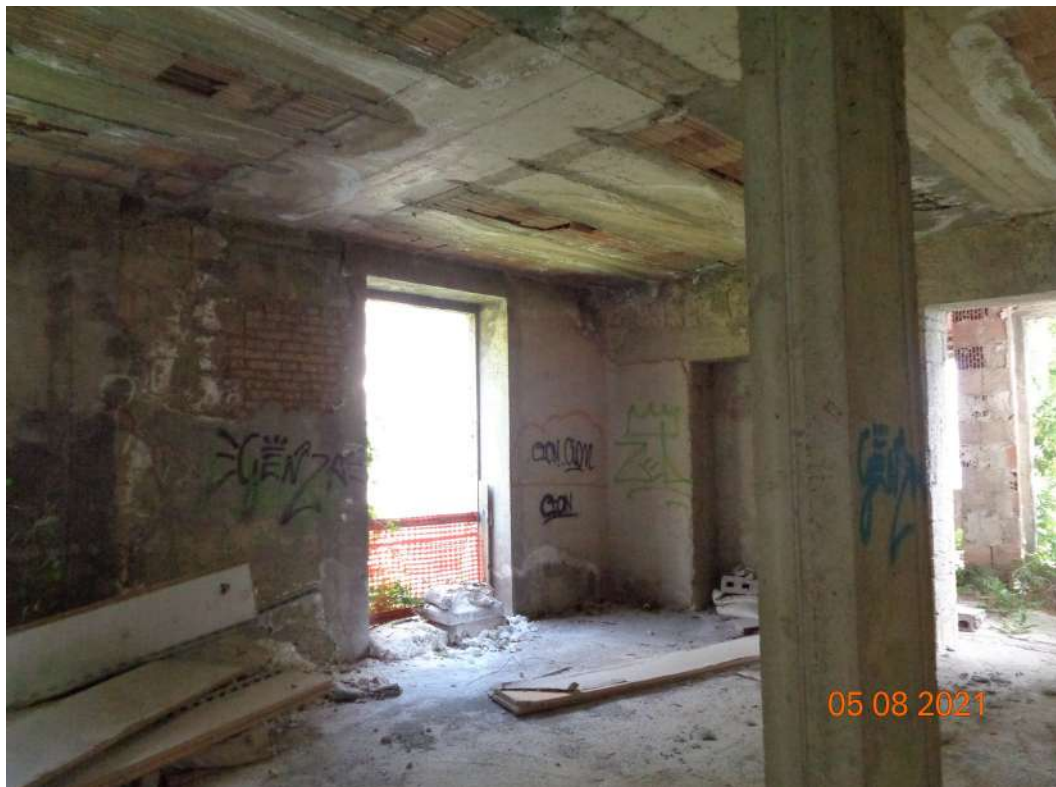
la foto n.13 mostra il p.t. (lato Nord) ove si rilevano le opere eseguite in c.a. dei solai ed in primo piano il setto in calcestruzzo armato di rafforzamento sismico.
