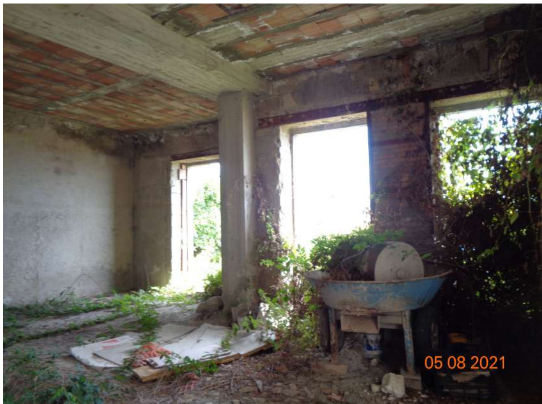
La foto n.12 mostra il piano terra ove sono visibili le opere strutturali eseguite quali pilastri, travi in c.a. e solai latero-cementizi.
