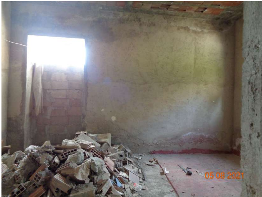
La foto n.11 mostra le tramezzature interne che sono state demolite in ossequio ai disposti del Comune di Napoli
