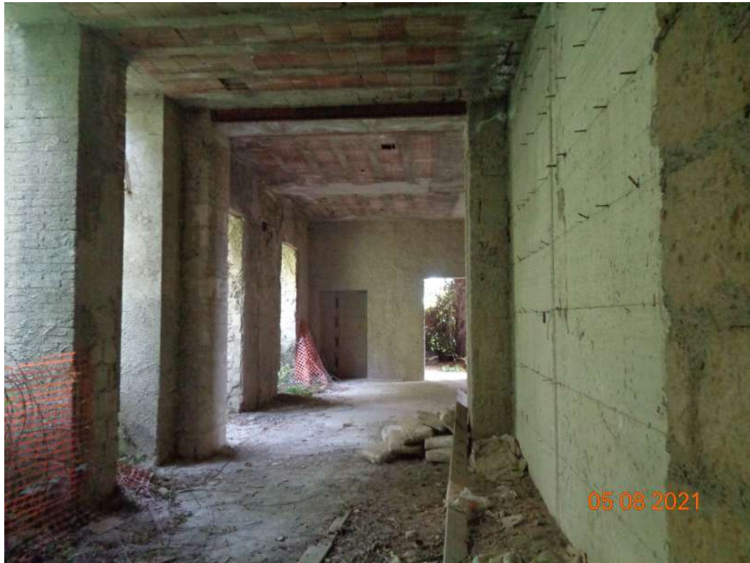
la foto n.13 mostra il p.t. (lato Nord) ove si rilevano le opere eseguite in c.a. dei solai ed in primo piano il setto in calcestruzzo armato di rafforzamento sismico.
