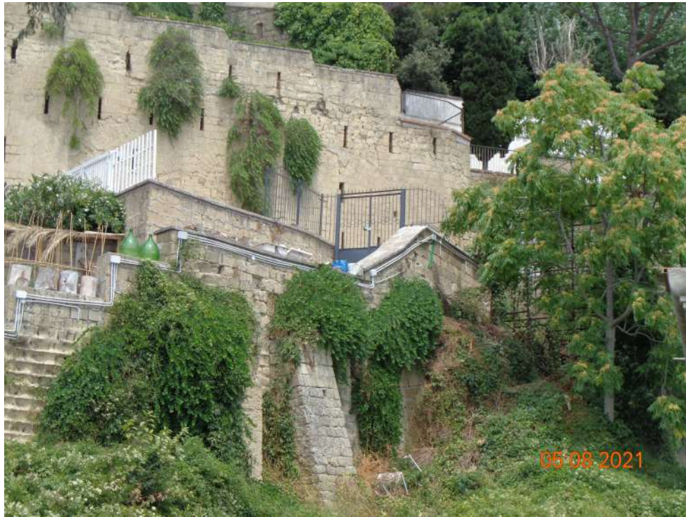
La foto n.09 mostra il confine ovest ed in particolare l'accesso da Via Caccaviello che, abusivamente i locali hanno posto una cancellata abusiva che impedisce anche l'accesso a parte dei gradoni del Petraio.
