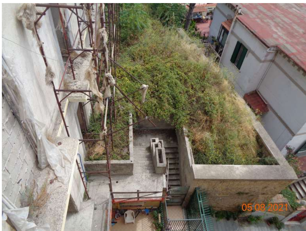
La foto n.04 mostra dall'alto la scalinata che da accesso al piano terra del "Fabbricato Secondario" nonché l'incolta area a verde annessa al compendio.
