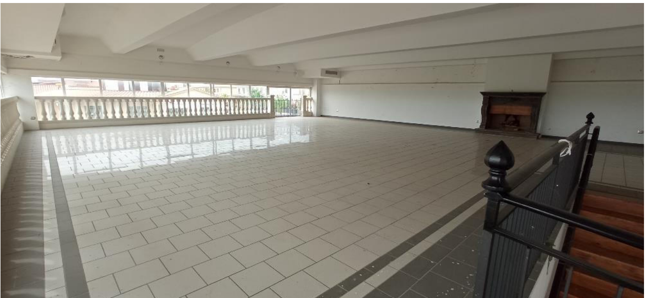
Foto n. 12. Piano primo, zona "vendita"
