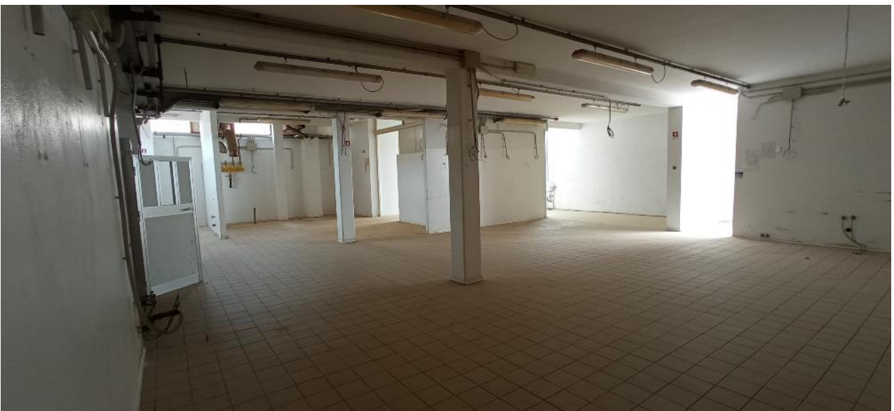
Foto n. 9. Piano terra, zona "laboratorio".
