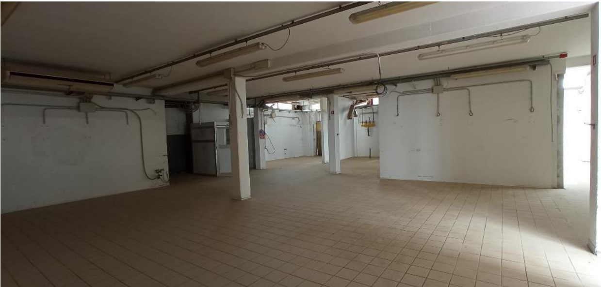
Foto n. 8. Piano terra, zona "laboratorio".
