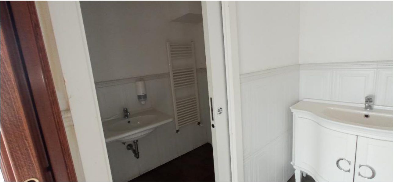
Foto n. 7. Piano terra, bagno zona "vendita".
