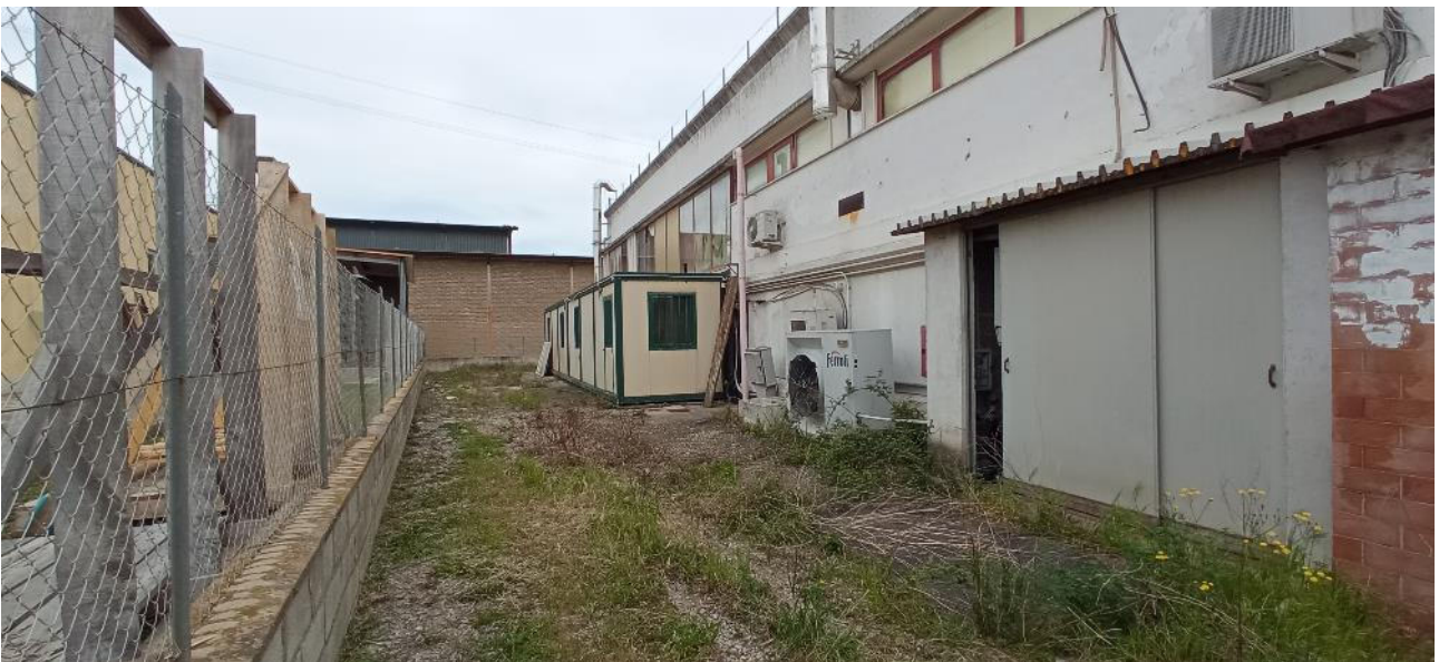
Foto n. 3. Vista panoramica, retro.
