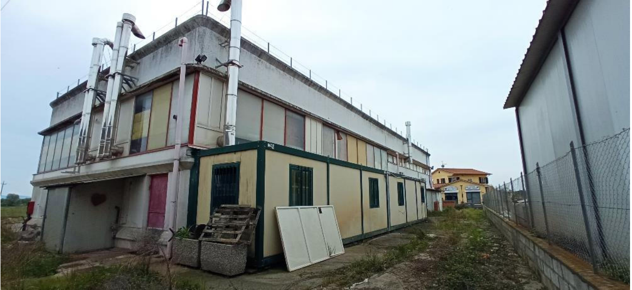
Foto n. 4. Vista panoramica, retro
