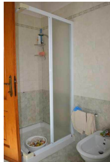
foto 23 - sub 2 (bagno 2) – Anche la cabina e il piatto doccia sono pensati per garantire ampiezza sufficiente per le esigenze di utenza diversamente abile.
