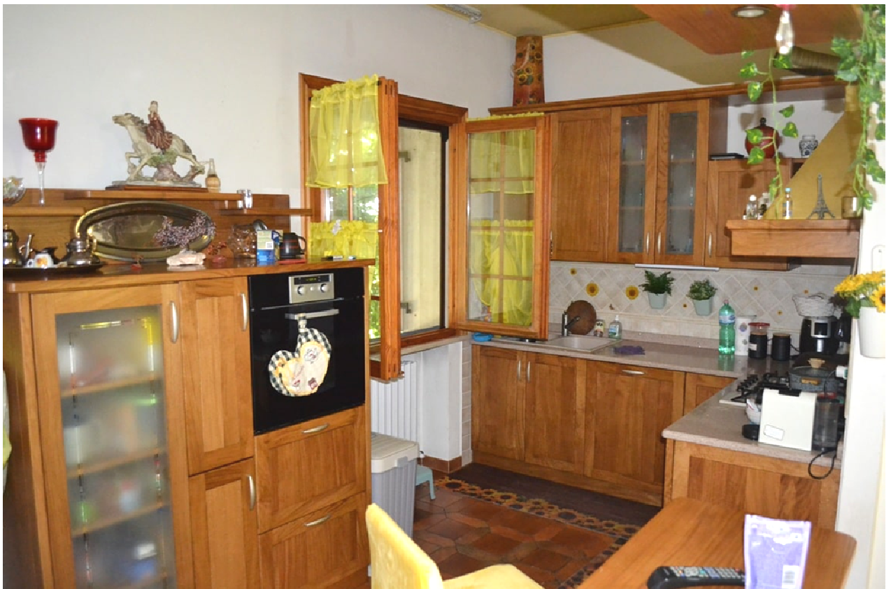
foto 2 – m.n. 378 sub 1 (cucina) – Le pareti attrezzate del locale sono piastrellate in ceramica smaltata fino all'intradosso degli arredi pensili. La cappa di aspirazione sopra il fornello è statica, mancando un terminale d'espulsione in copertura. Gli infissi, qui come ovunque altrove, sono telai in legno con persiane.
