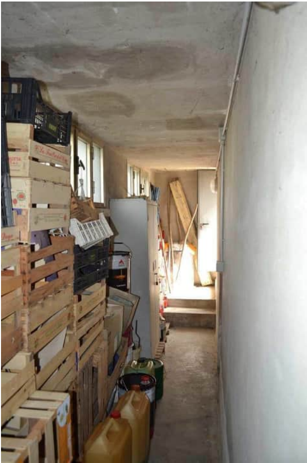
foto 33 - m.n. 378 - sub 1 (corridoio) - Il disbrigo che interconnette la cantina e il locale caldaia è lungo quasi 8.70m ed è dotato di tre finestre sotto balastra.
