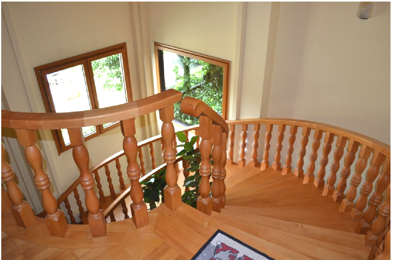
foto 15 – m.n. 378 sub 1 (vano scala) – L'interno del corpo di fabbrica turrato è dominato da una maestosa scala elicoidale finita in legno massiccio chiaro. I gradini hanno larghezza lorda pari a 1.30m, col primo a fungere da maestà al piede raggiungendo il metro e novanta. Si tratta di diciotto pedate e di diciannove alzate – le seconde da circa 16.5cm ognuna – a sbarcare su un ballatoio con balaustra in parte curvilinea.
