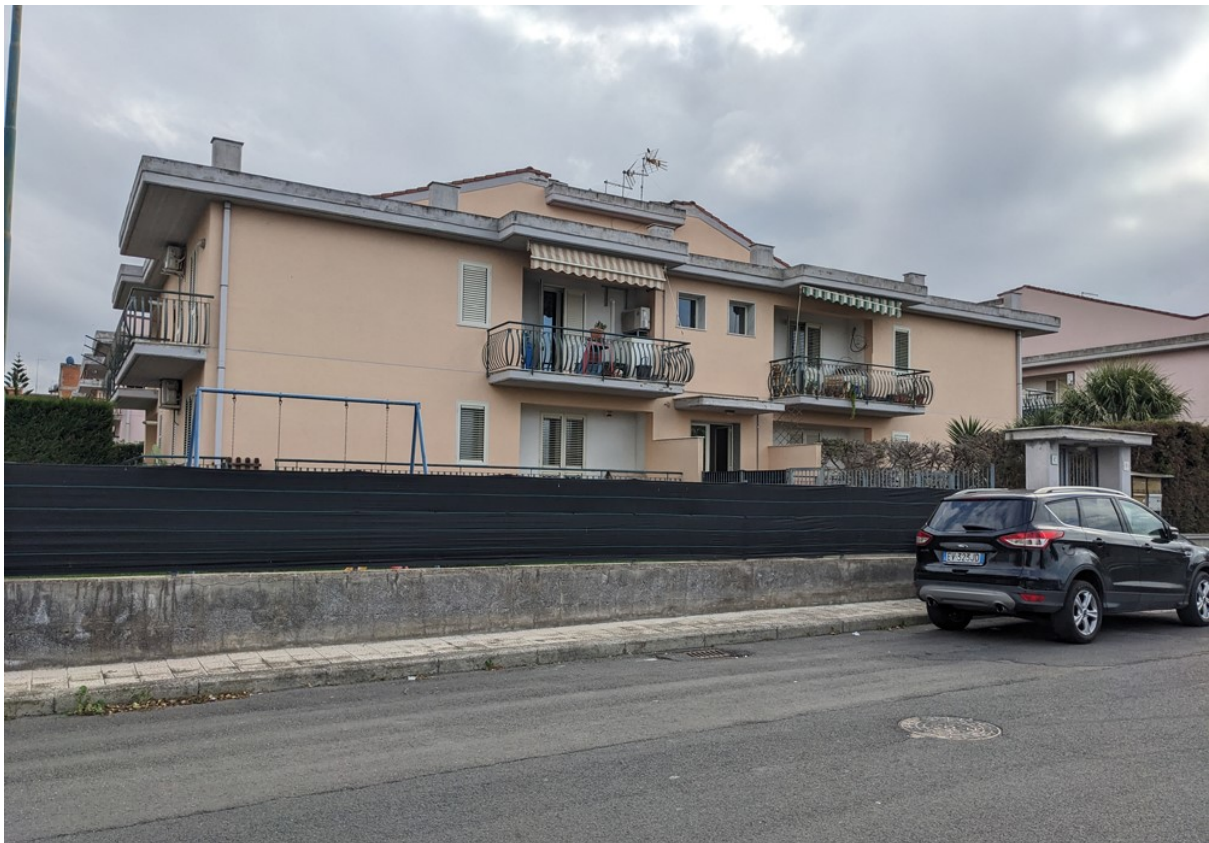
Viste dell'Edificio C, sul lato con civico 11
