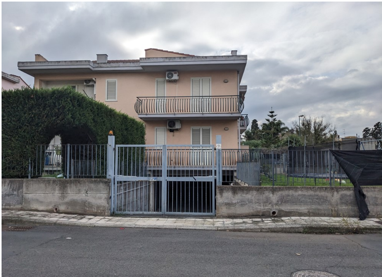
Viste dell'Edificio C, sul lato con civico 9
