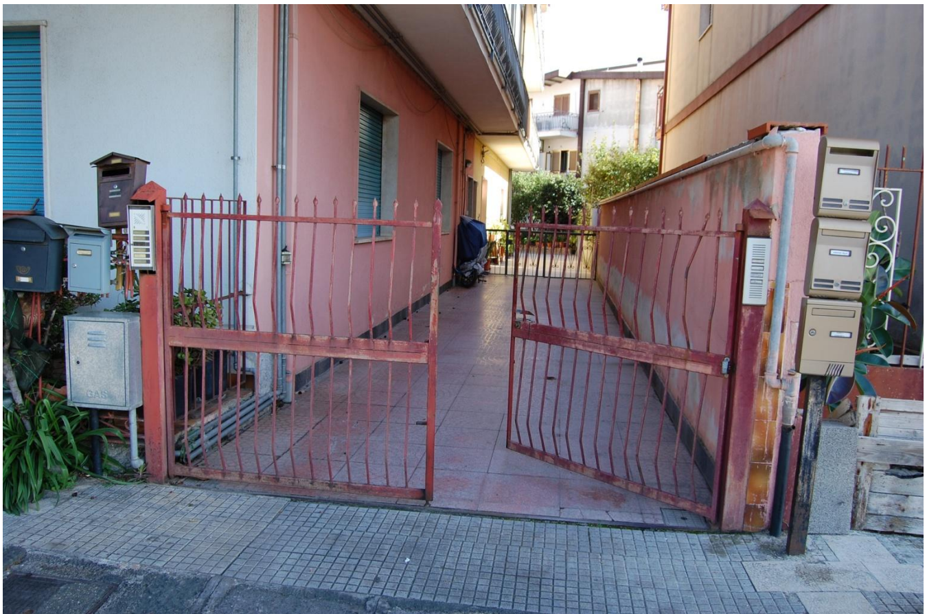
FOTO 6: cancello di accesso al cortile interno
