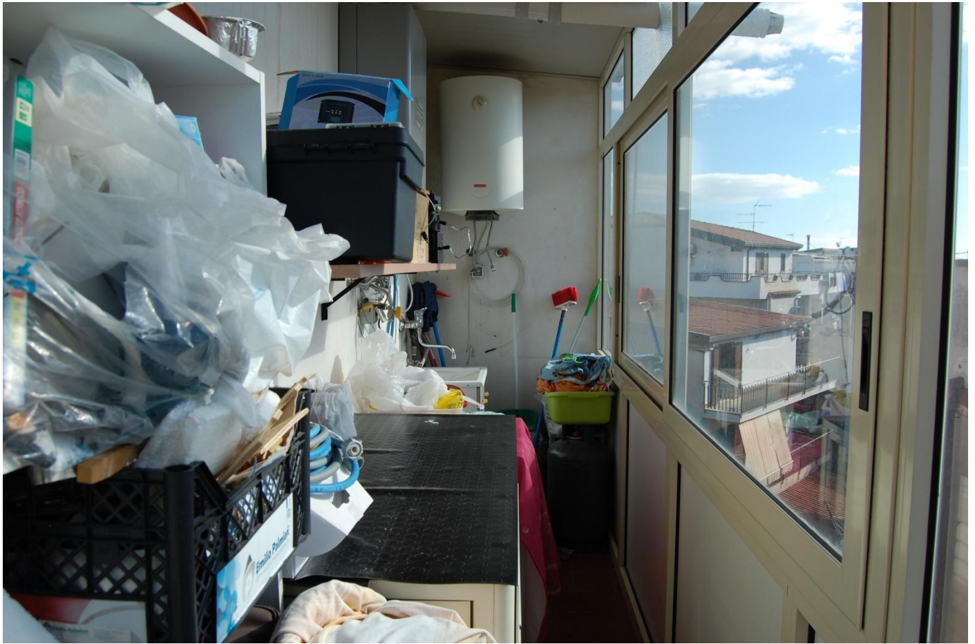
FOTO 21: porzione balcone chiusa in alluminio e vetro
