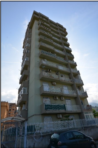
All. 7 – Foto 7 Edificio di Via Gen. D. Chinnici n. 70
