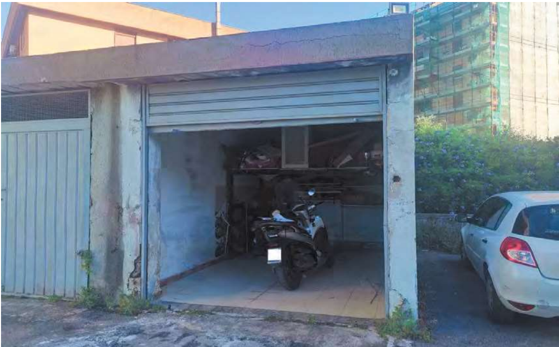
Foto 3 - Ingresso box (sub. 27) di Via Gen. D. Chinnici, 70-72
