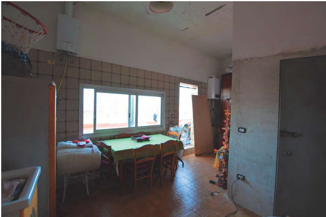
Foto 23 - Vano del 12° piano di Via Gen. D. Chinnici, 70
