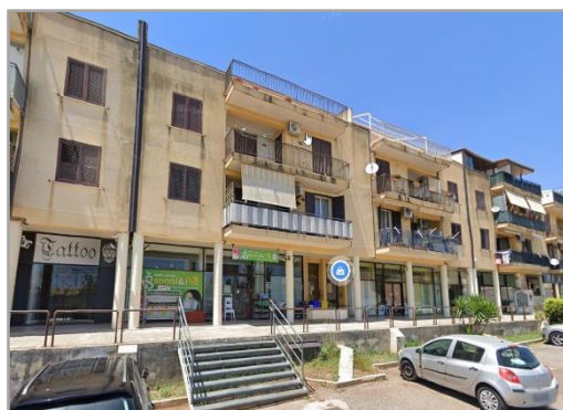
Foto dell'edificio con ingresso da Via Giudice
