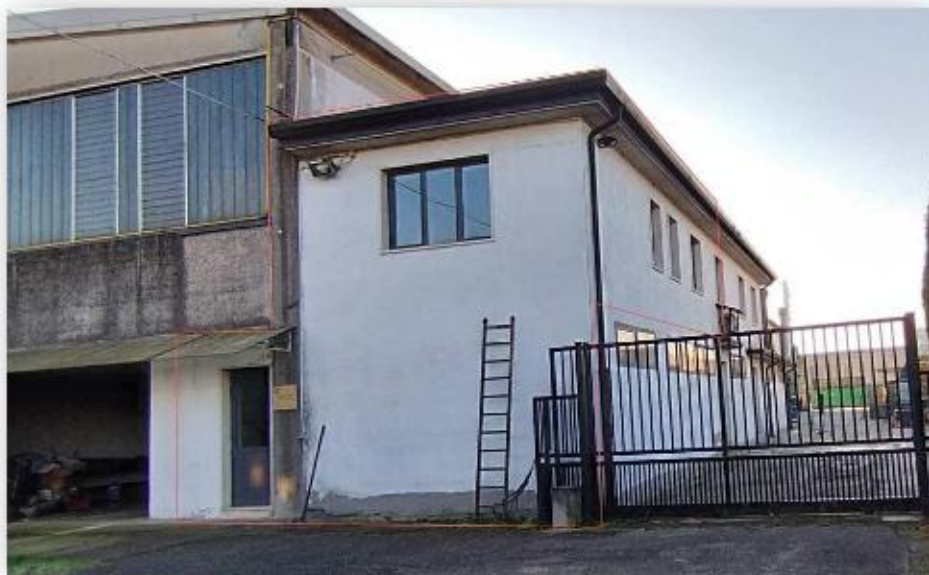
Lato nord esterno palazzina uffici sub 10
