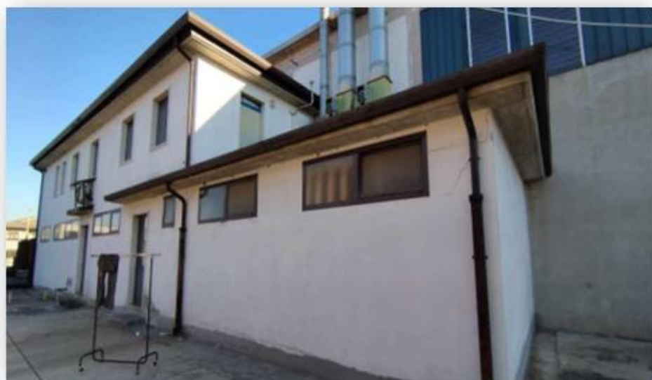
Lato ovest esterno palazzina uffici sub 10
