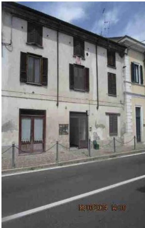
Ingresso al vano scala da Corso Repubblica
