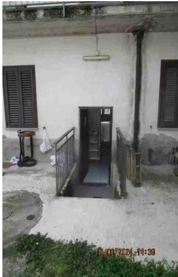
Ingresso al vano scala dal cortile lato Nord
