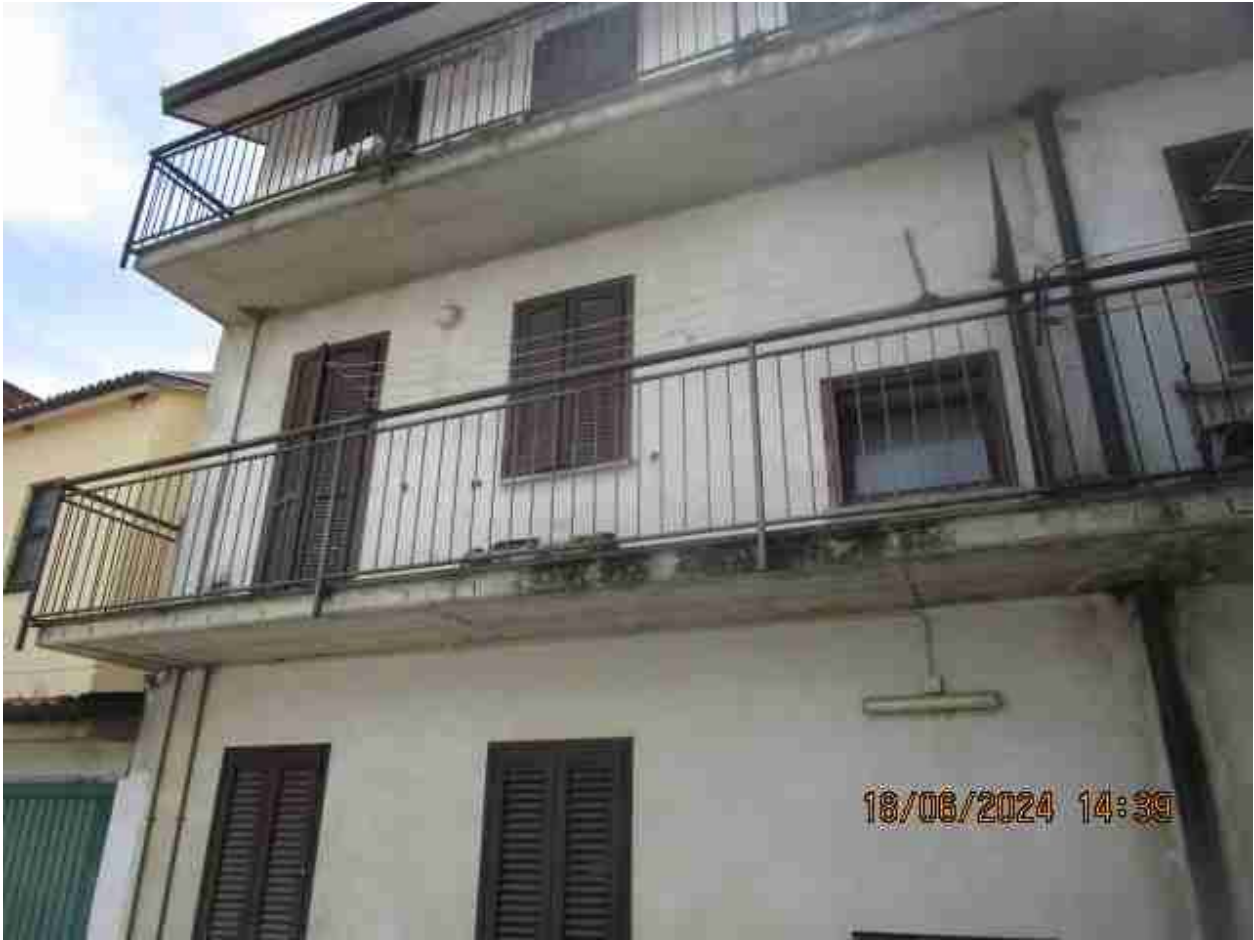
Prospetto su cortile comune
