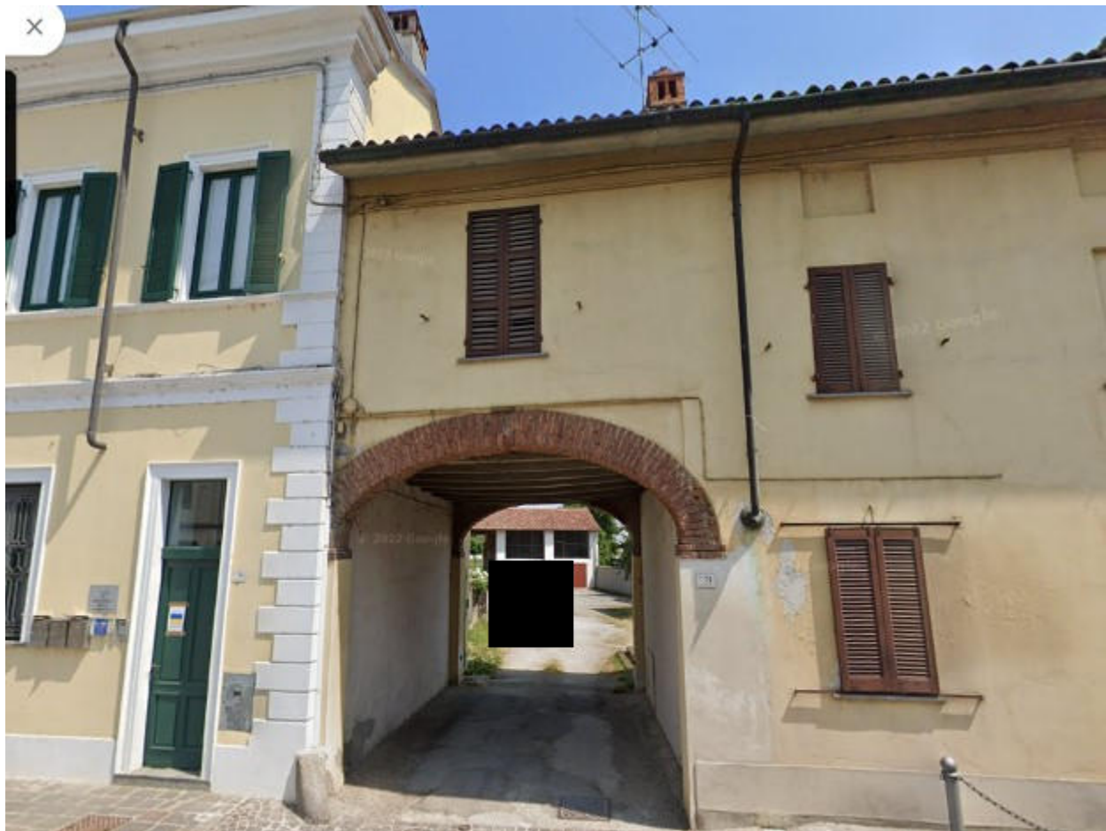
Ingresso al cortile da Corso Repubblica
