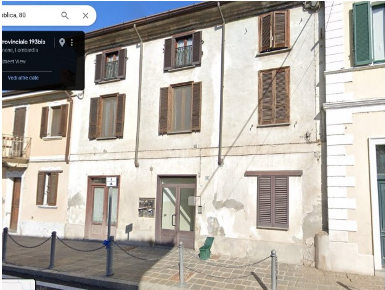
Ingresso al vano scala da Corso Repubblica
