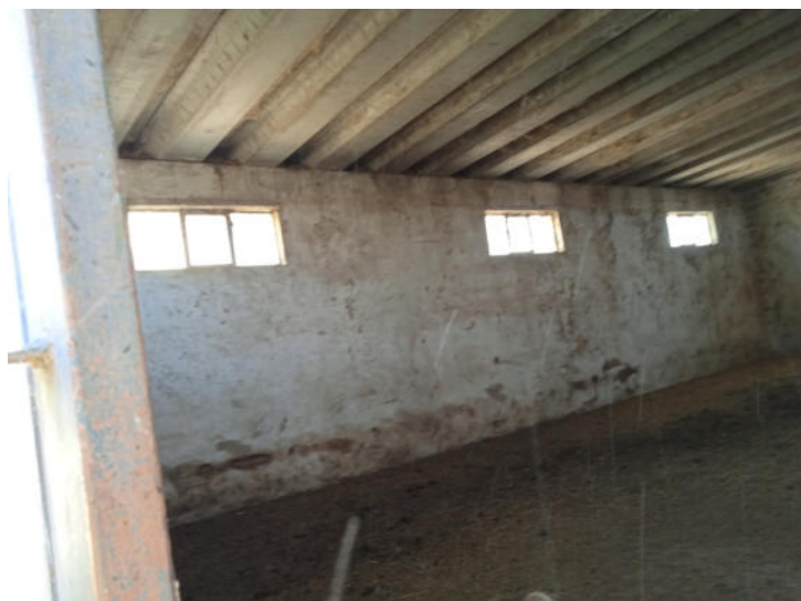
Foto n. 54 – Fabbricato C - Part. 405 sub 4
