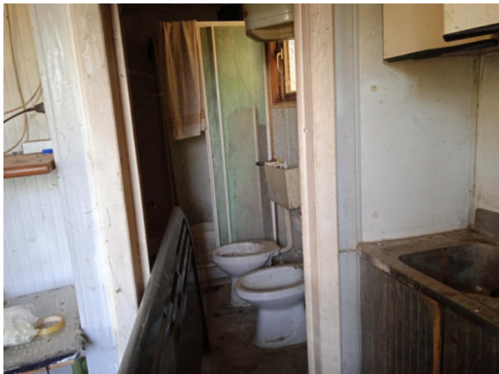
Foto n. 63 – Fabbricato E - Vista interna
