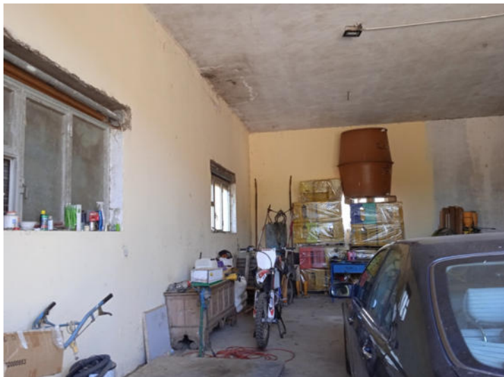
Foto n. 9 – Fabbricato A - Piano terra - Part. 405 sub 3
