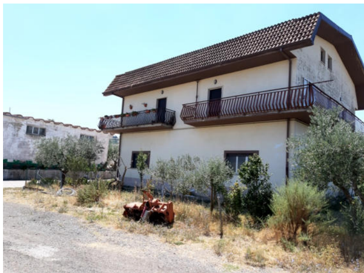
Foto n. 6 – Fabbricato A - Vista esterna
