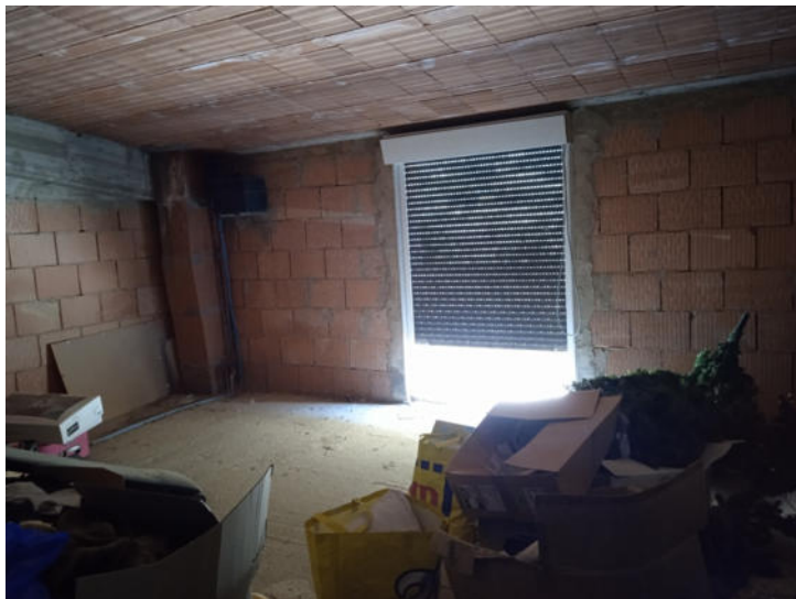
Foto n. 23 – Fabbricato A - Piano secondo - Part. 405 sub 10
