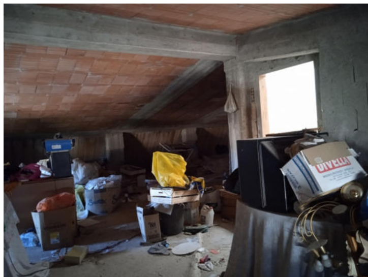
Foto n. 34 – Fabbricato A - Piano secondo - Part. 405 sub 11
