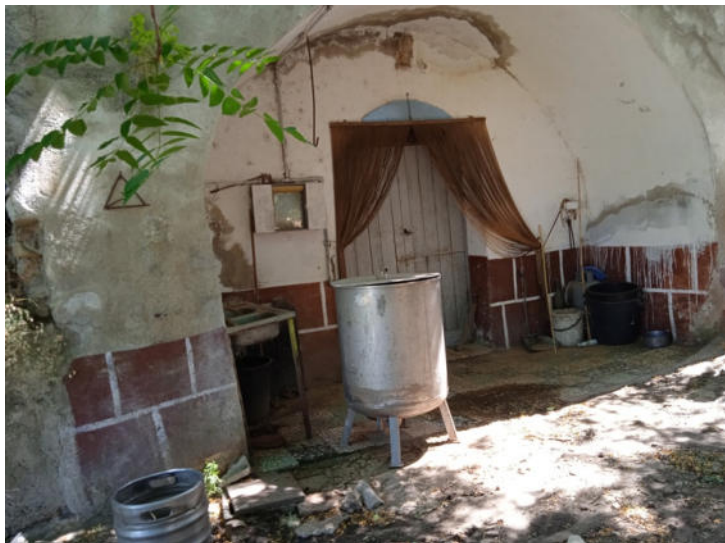
Foto n. 45 – Fabbricato B - Piano seminterrato - Part. 405 sub 5
