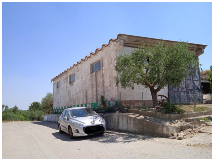
Foto n. 50 – Fabbricato C - Vista esterna
