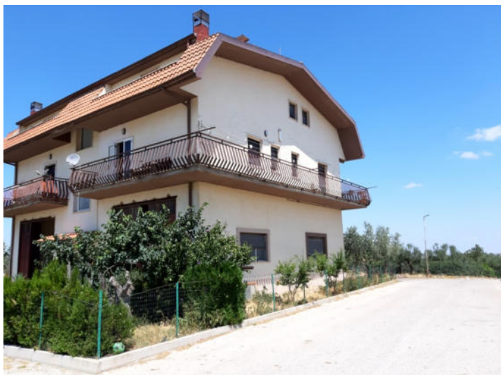
Foto n. 7 – Fabbricato A - Vista esterna
