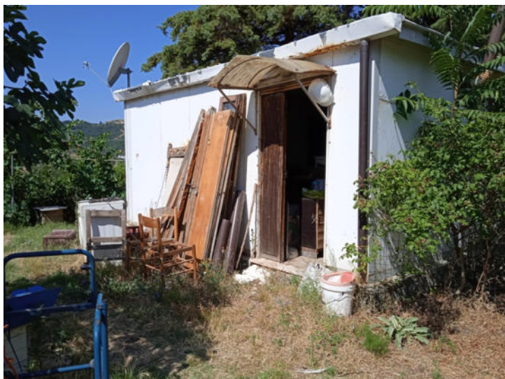
Foto n. 60 – Fabbricato E - Vista esterna
