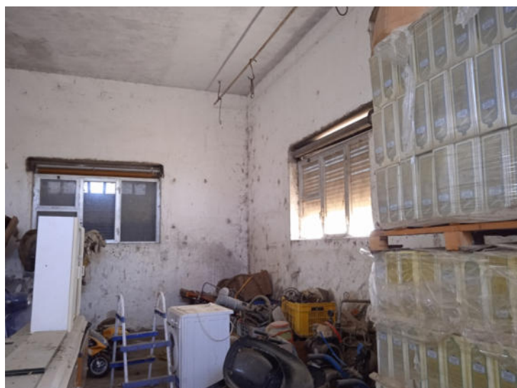
Foto n. 12 – Fabbricato A - Piano terra - Part. 405 sub 3
