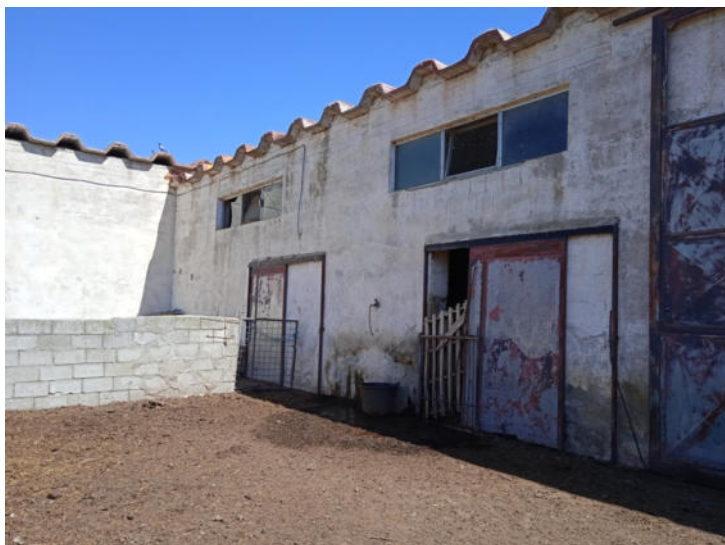
Foto n. 51 – Fabbricato C - Vista esterna
