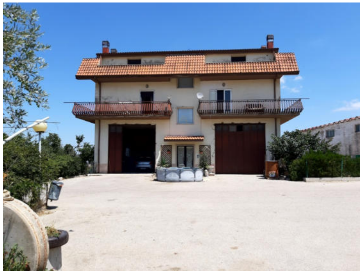
Foto n. 4 – Fabbricato A - Vista esterna
