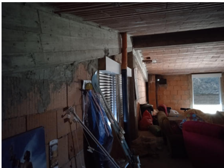
Foto n. 33 – Fabbricato A - Piano secondo - Part. 405 sub 11
