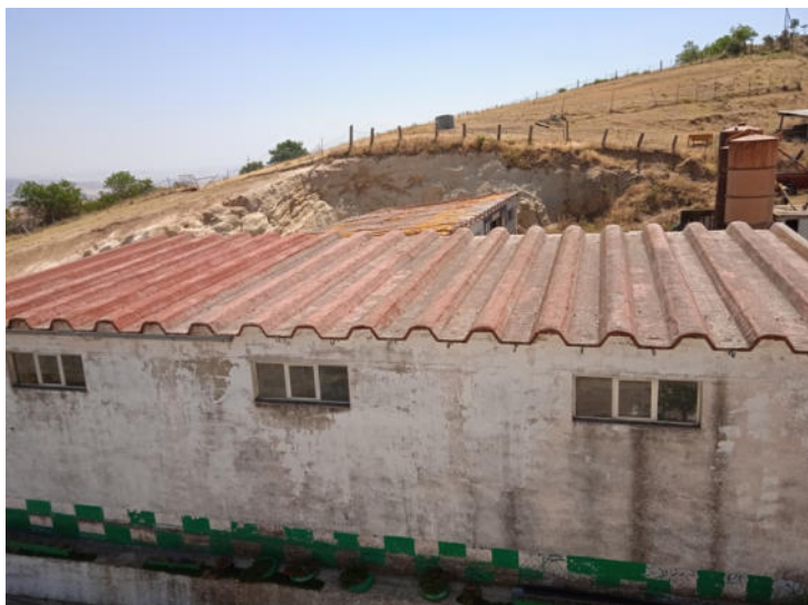
Foto n. 49 – Fabbricato C - Vista esterna
