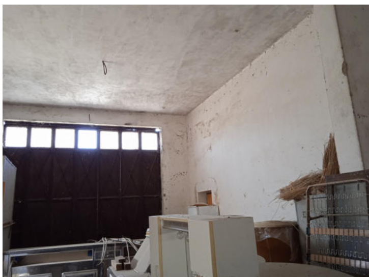
Foto n. 11 – Fabbricato A - Piano terra - Part. 405 sub 3
