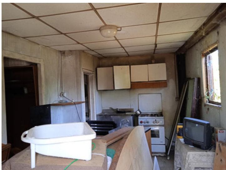
Foto n. 62 – Fabbricato E - Vista interna
