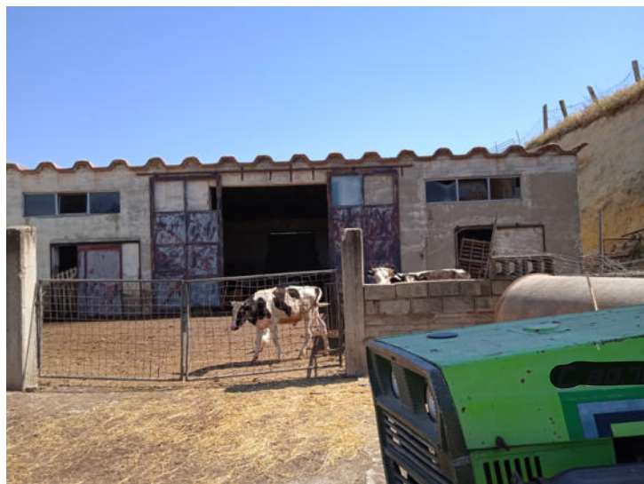
Foto n. 52 – Fabbricato C - Vista esterna
