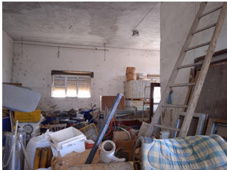
Foto n. 10 – Fabbricato A - Piano terra - Part. 405 sub 3
