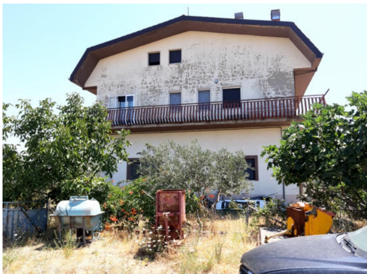
Foto n. 5 – Fabbricato A - Vista esterna
