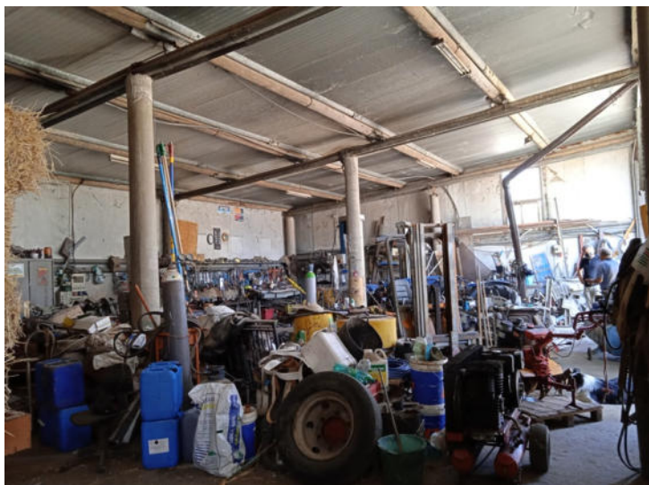
Foto n. 59 – Fabbricato D - Vista interna - Immobile non accatatasto
