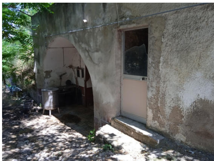
Foto n. 38 – Fabbricato B - Vista esterna
