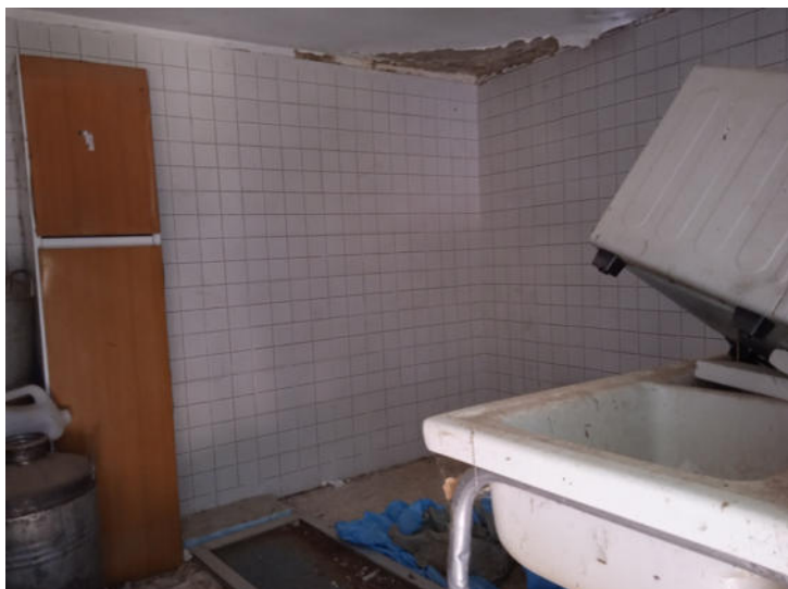
Foto n. 47 – Fabbricato B - Piano seminterrato - Part. 405 sub 5
