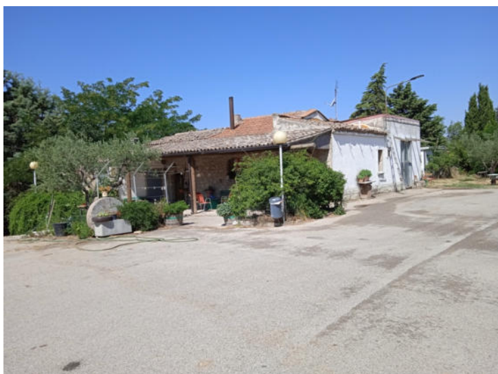
Foto n. 37 – Fabbricato B - Vista esterna
