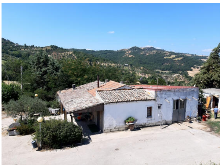
Foto n. 35 – Fabbricato B - Vista esterna
