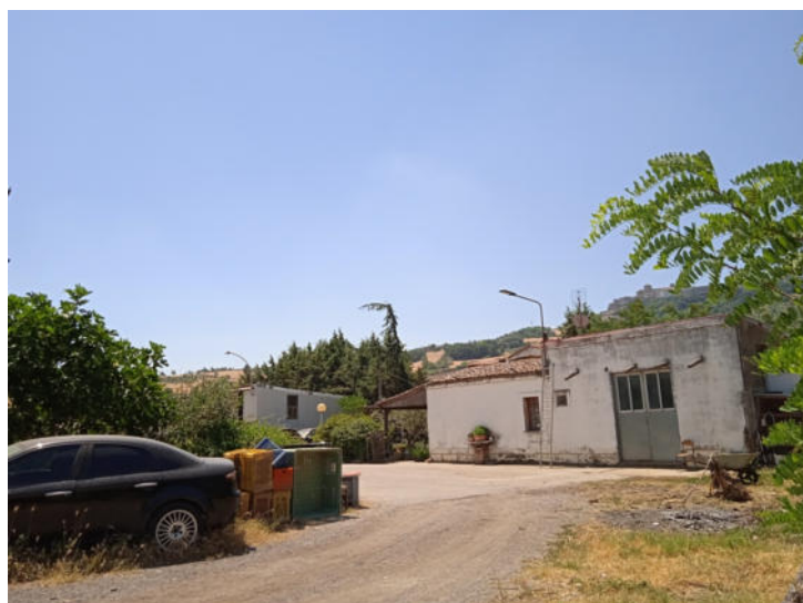
Foto n. 36 – Fabbricato B - Vista esterna
