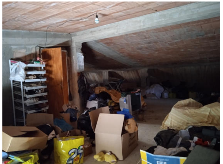
Foto n. 24 – Fabbricato A - Piano secondo - Part. 405 sub 10
