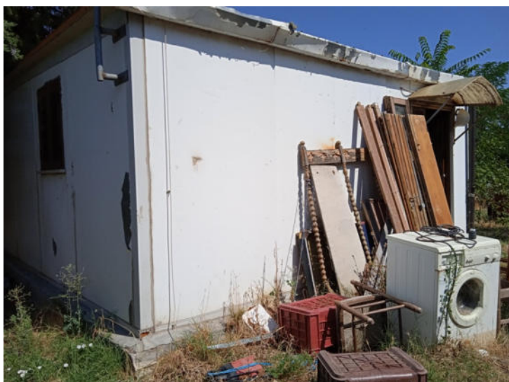
Foto n. 61 – Fabbricato E - Vista esterna
