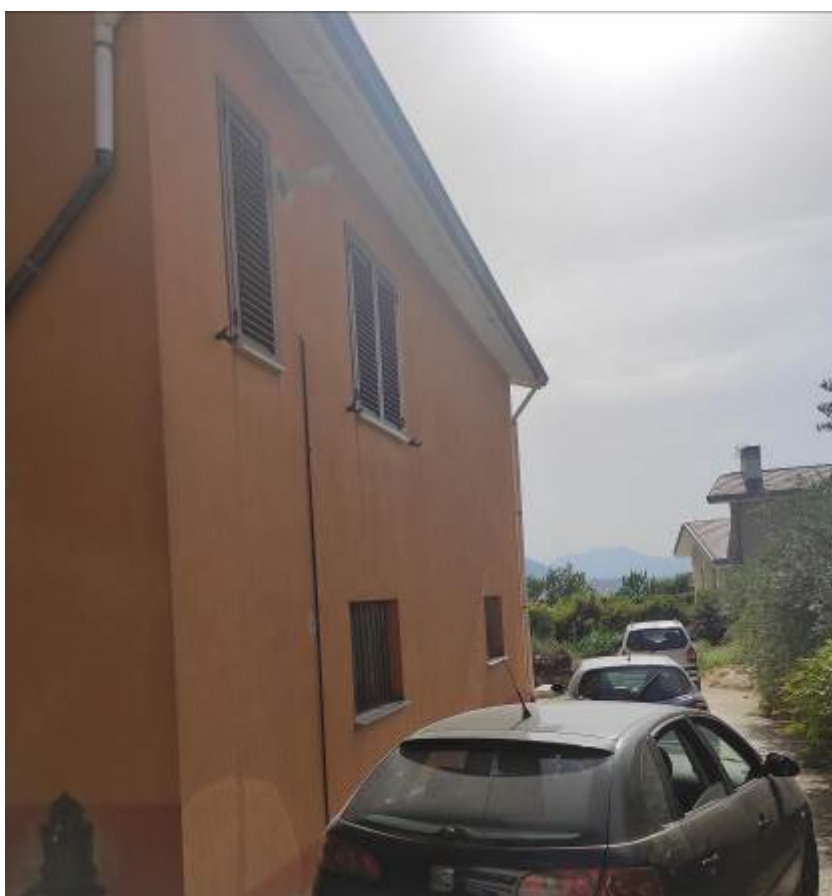
2_Vista del fabbricato - lato nord
