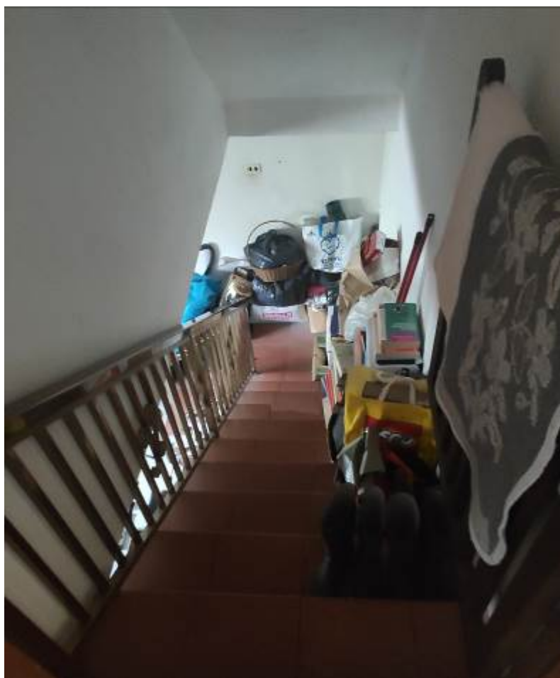
16_Piano Primo –Abitazione - la scala interna di collegamento con il piano terra
