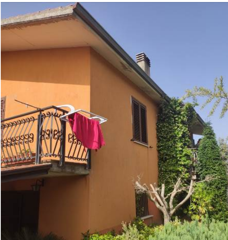
5 - 6_Vista del fabbricato - lato sud
