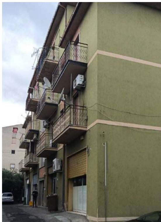
foto n° 1 - Vista Esterna Immobile Bene 1
