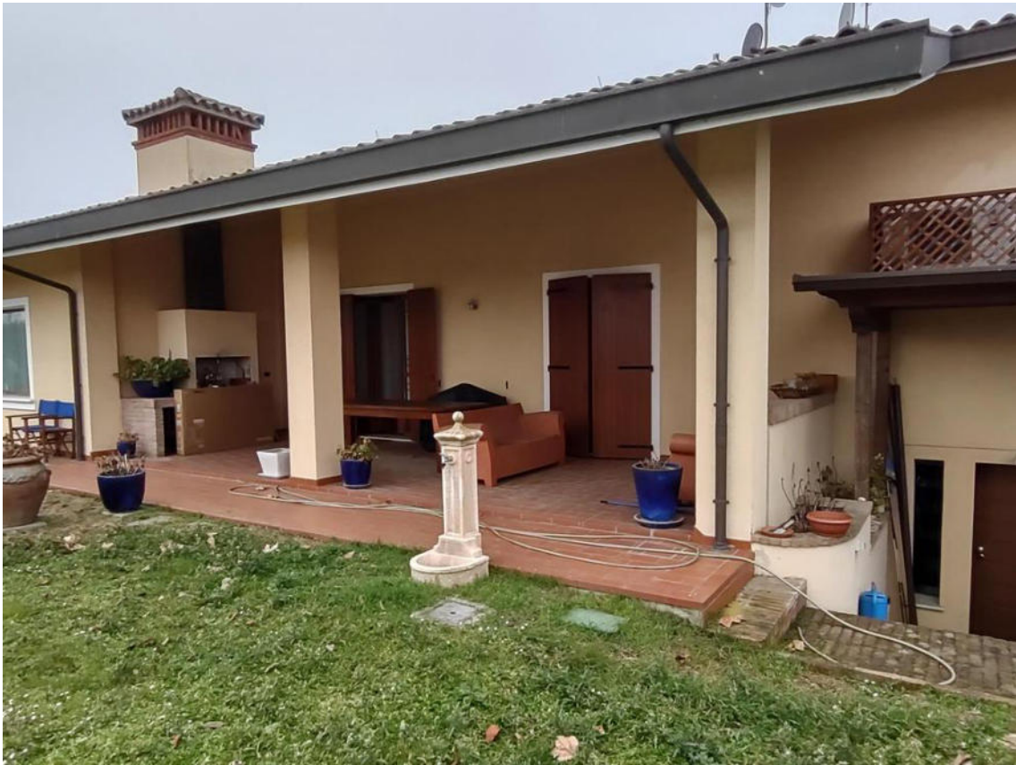
FOTO 9. Abitazione: il portico accessibile dalla cucina
