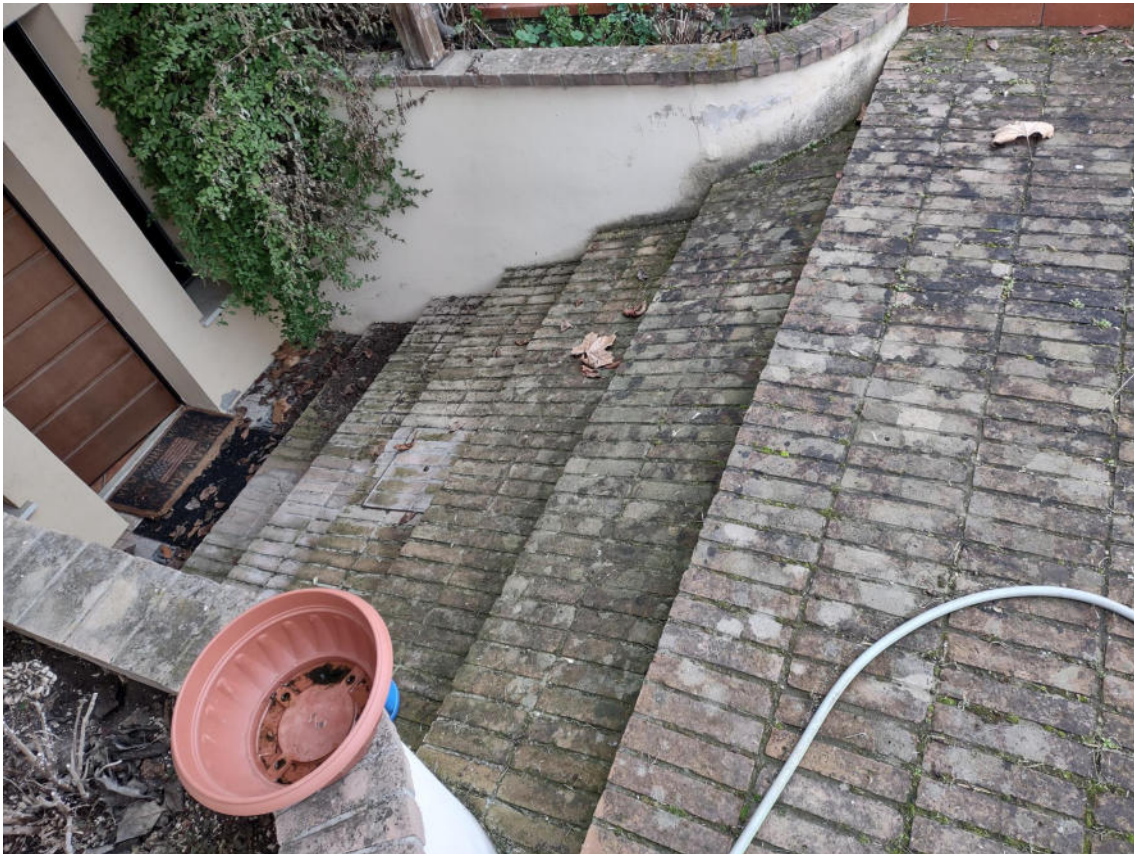
FOTO 25. L'accesso esterno al piano interrato: ex rampa trasformata in scala
