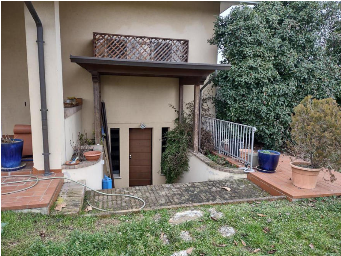
FOTO 24. L'accesso esterno al piano interrato
