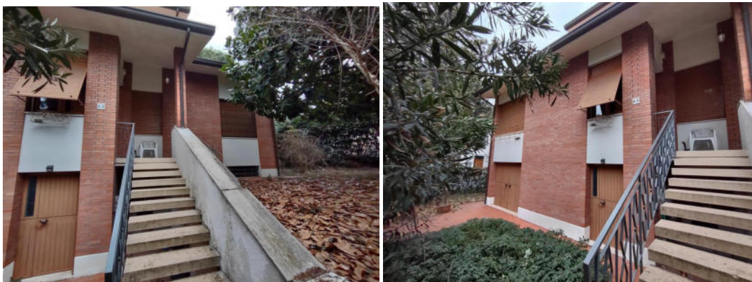
Fronte principale su Via Bellini e scala esterna di ingresso all'abitazione
