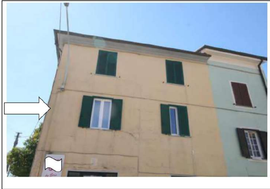
VISTA PIANO DI PERTINENZA
