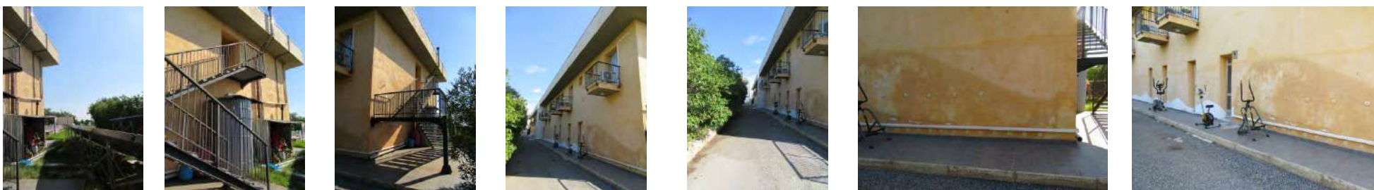
Foto da 251 a 254 – Prospetto Ovest
