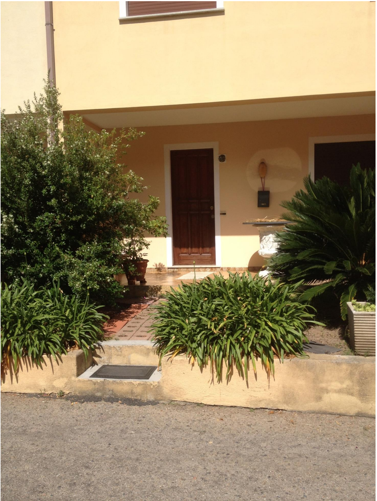
Foto n° 02) Particolare ingresso immobile oggetto di esecuzione.
