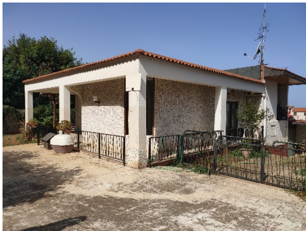
Esterno dall'ingresso angolo Est-Nord
