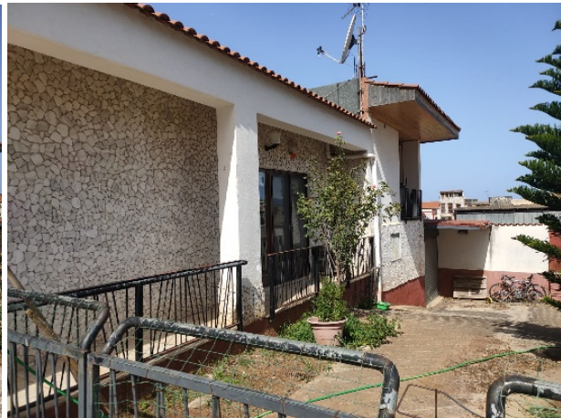
Esterno lato Nord
