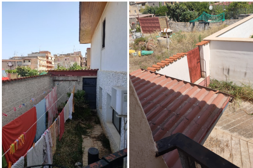
vista dal piano terra sul lato Ovest e sul lato a Nord
