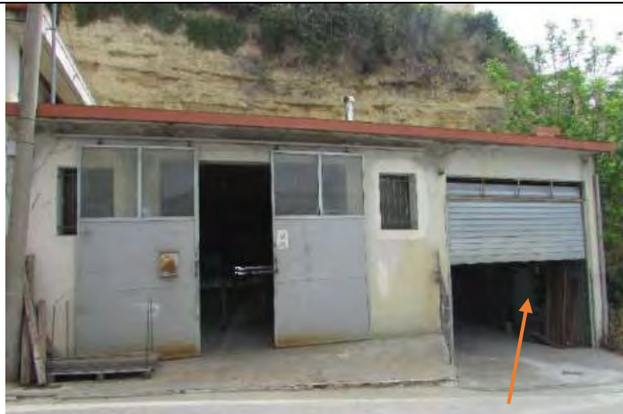
Foto 3 – Laboratorio – Autorimessa – Esterno -
