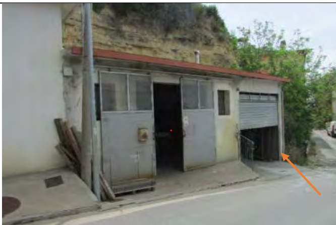
Foto 1 – Laboratorio – Autorimessa – Esterno -
