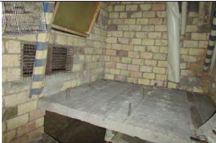
Foto 15 - Particolare Fondaco Piano Interrato -
