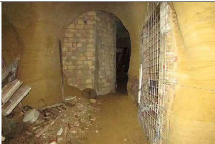
Foto 13 - Particolare Piano Interrato -
