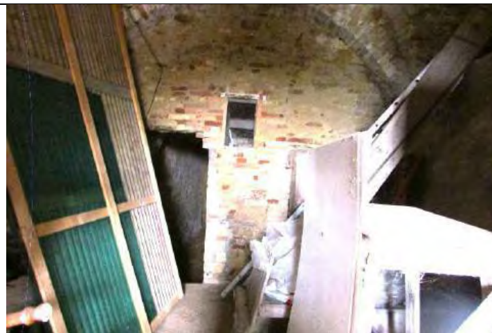
Foto 14 - Particolare Fondaco Piano Interrato -
