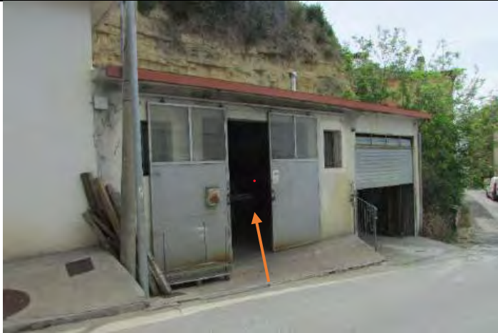
Foto 1 – Laboratorio – Autorimessa – Esterno -
