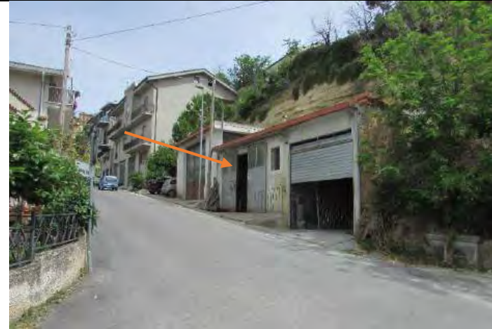
Foto 2 – Laboratorio – Autorimessa – Esterno -
