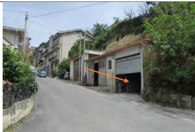
Foto 2 – Laboratorio – Autorimessa – Esterno -
