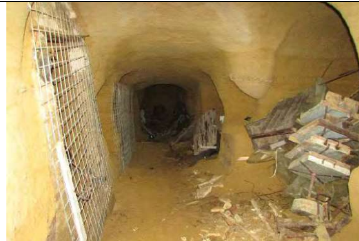
Foto 12 - Particolare Piano Interrato -
