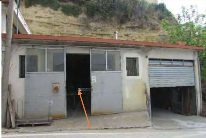
Foto 3 – Laboratorio – Autorimessa – Esterno -
