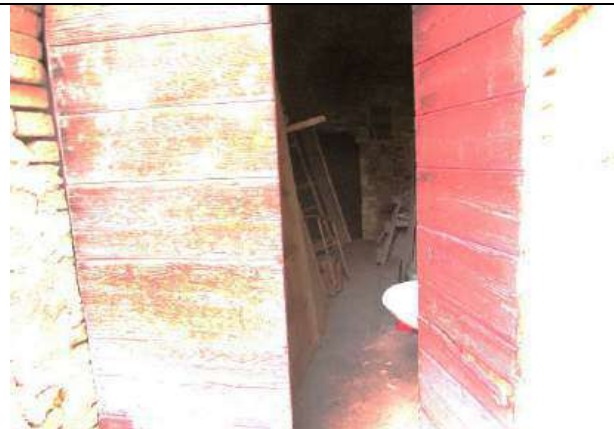
Foto 16 - Particolare Ingresso Piano Interrato -
