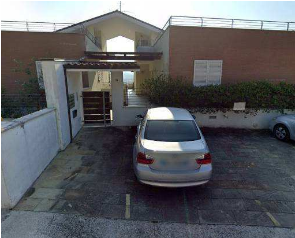
INGRESSO CONDOMINIALE E POSTO AUTO (SUB. 61)
