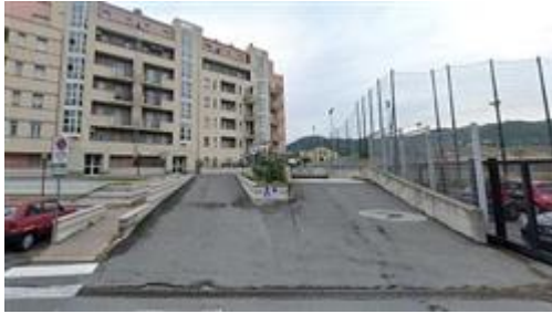
ingresso autorimesse da via Cadorna
