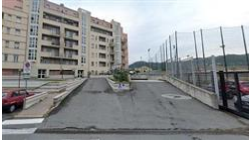
ingresso autorimesse da via Cadorna
