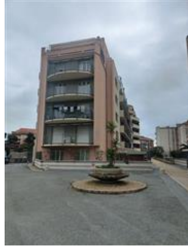
prospetto nord del fabbricato
