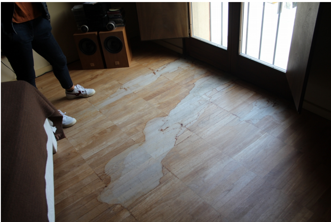
particolare pavimentazione camera da letto
