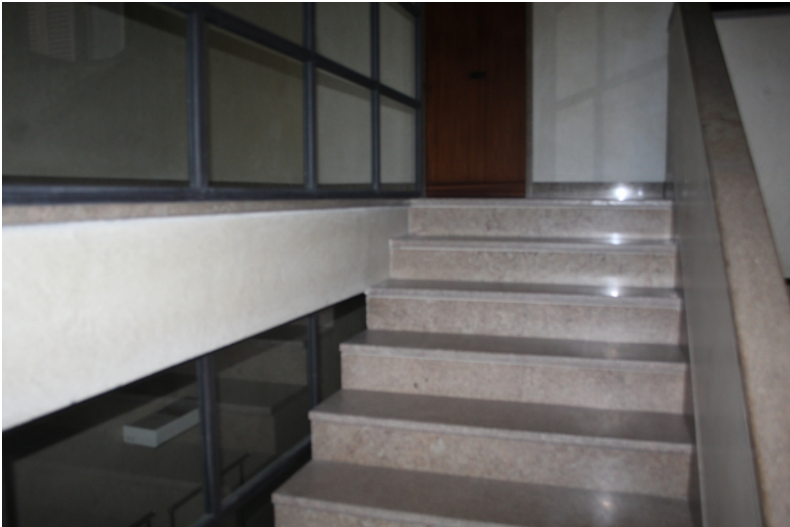
vano scala comune
