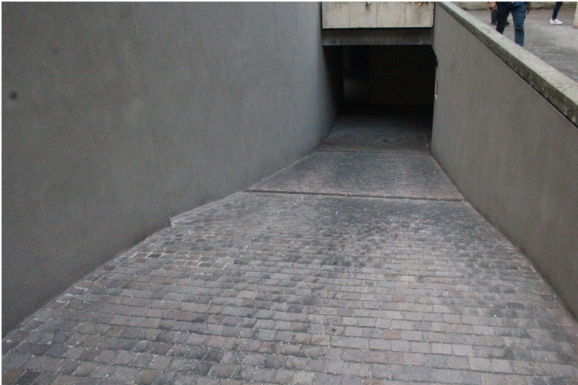
rampa di accesso al piano seminterrato
