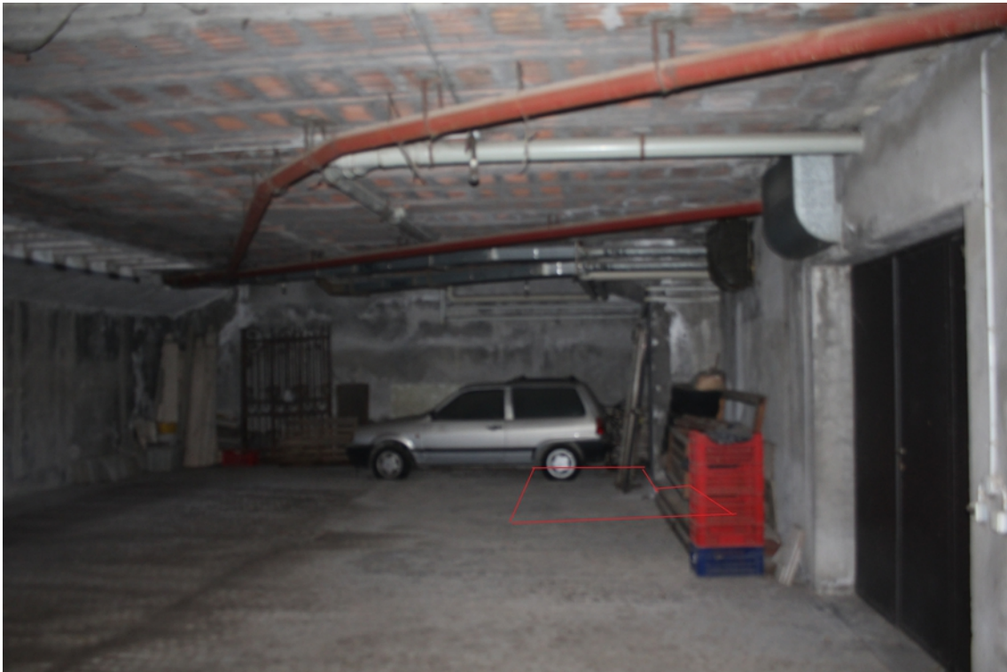
posto auto coperto al piano seminterrato
