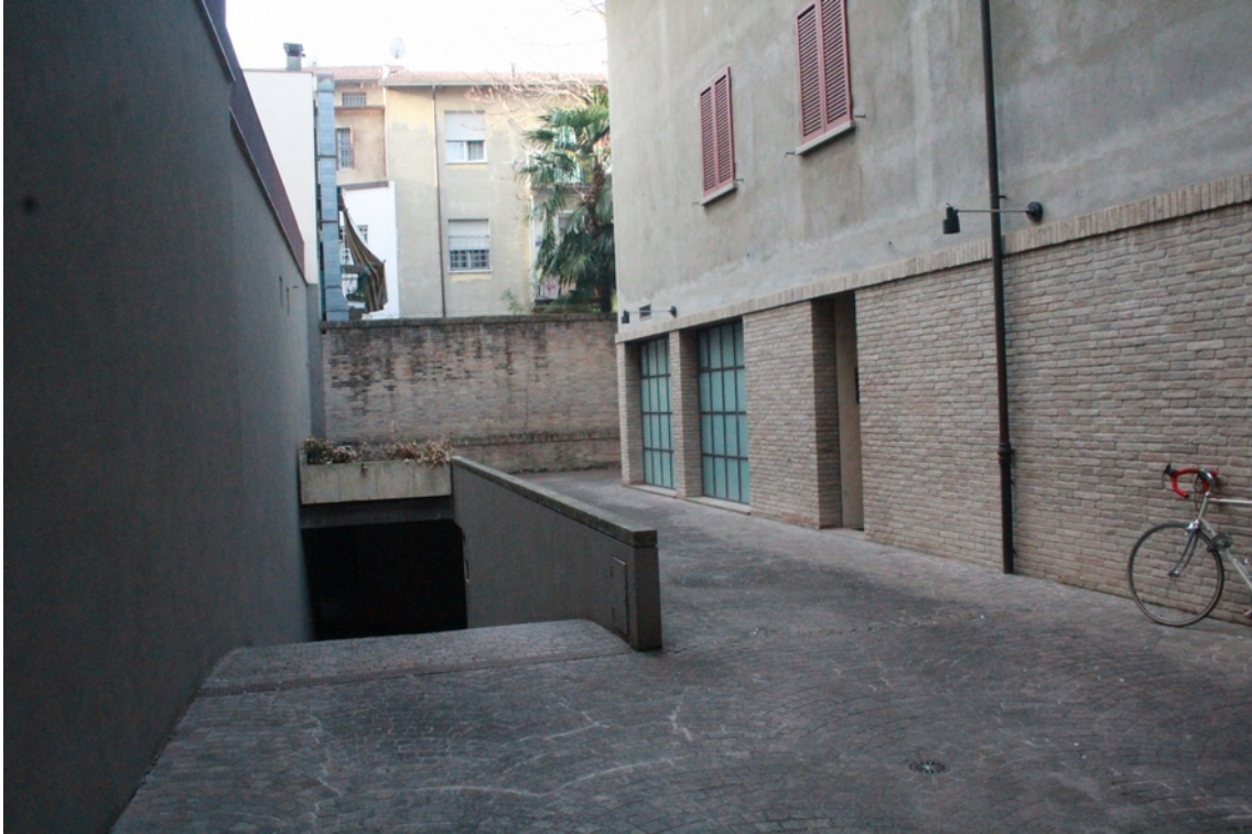
vista rampa di accesso al piano seminterrato
