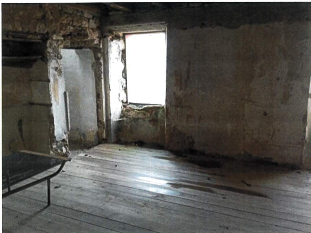
Figura 7 interni al piano primo
