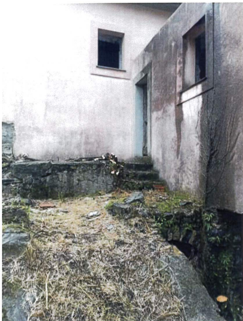
Figura 4 la scala di accesso al portoncino di ingresso
