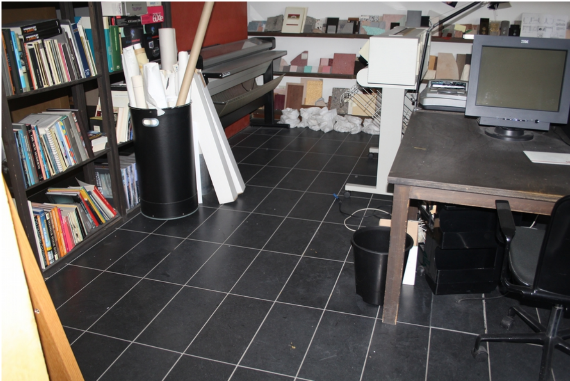
particolare pavimentazione ufficio
