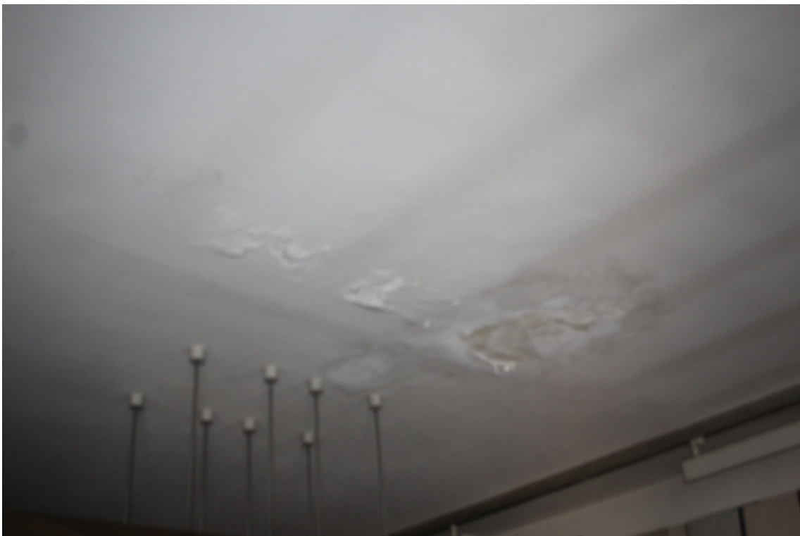
particolare soffitto ufficio
