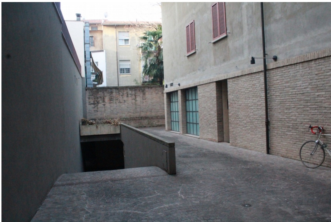
vista esterna rampa di accesso piano seminterrato
