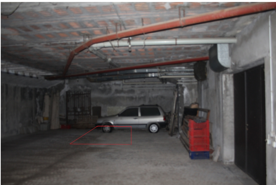
posto auto coperto piano seminterrato
