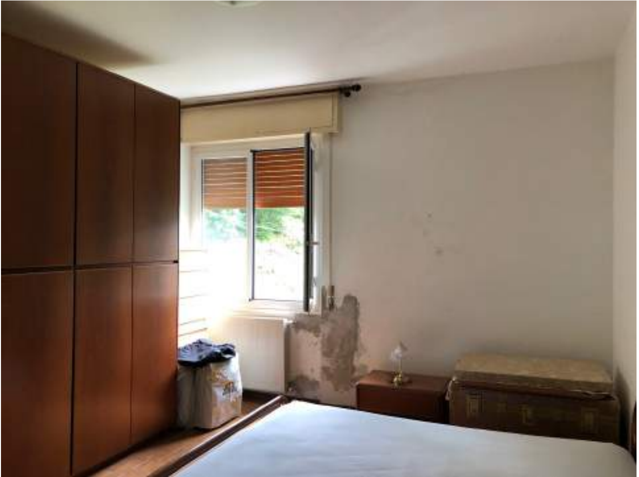
VISTA INTERNA FOTO N. 18
