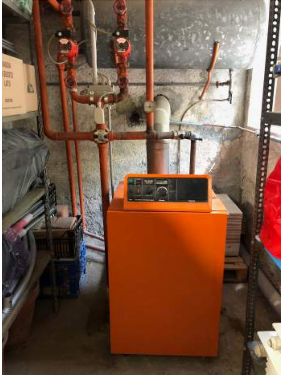
VISTA INTERNA FOTO N. 09
