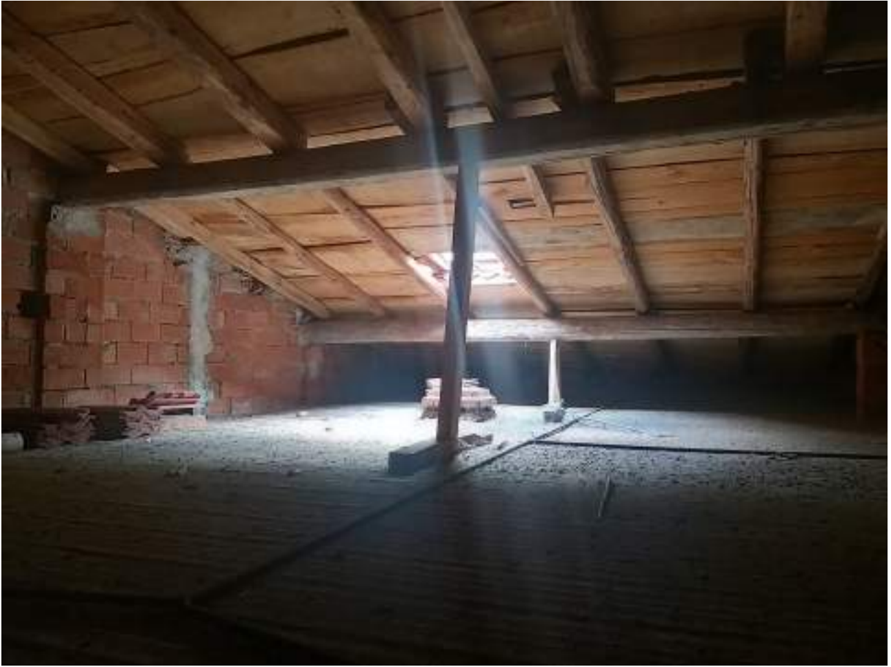
VISTA INTERNA FOTO N. 20
