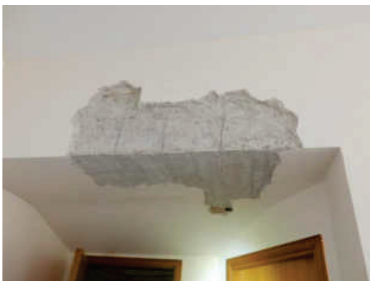
Foto n° 45 – particolare trave in c.a. su disimpegno accesso sub. n. 1 e n. 2 – Foto 27.02.2023
