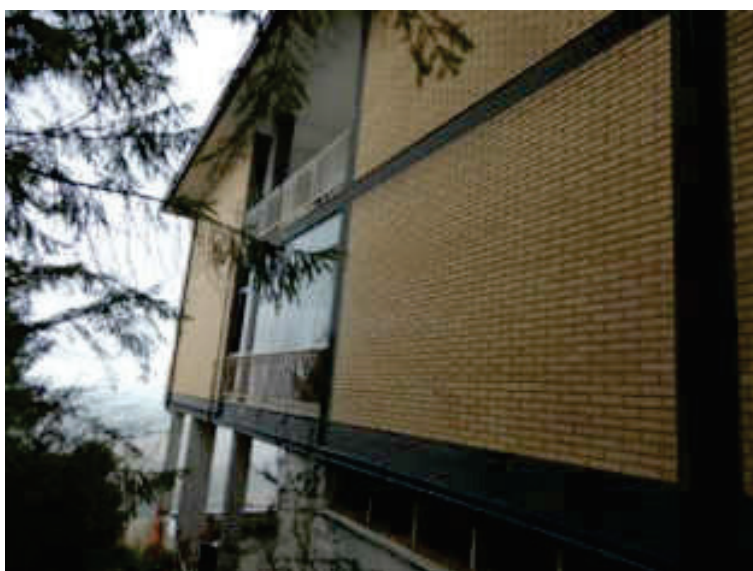
Foto n° 8 – vista spigolo Nord e parete Nord-Ovest – Foto 27.02.2023
