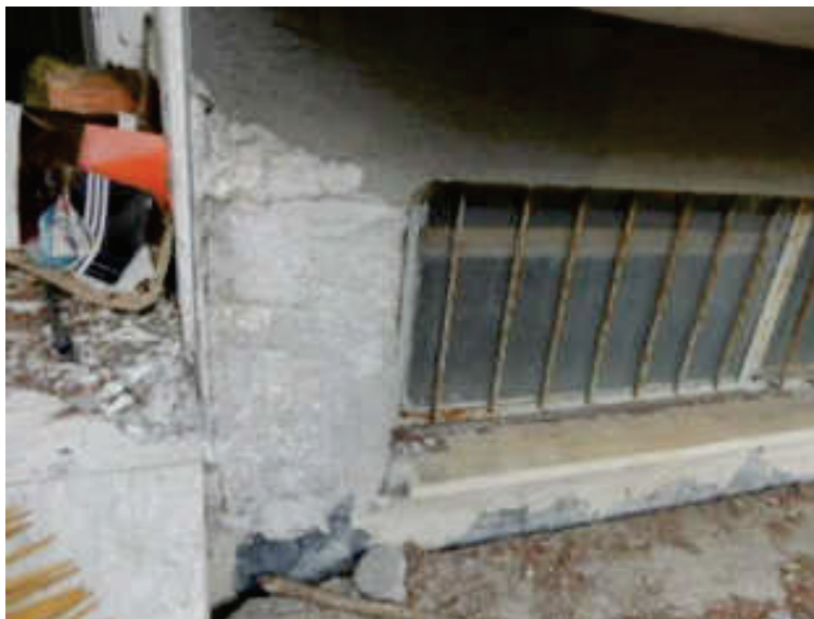
Foto n° 10 – vista particolare pilastro parete Sud-Ovest – Foto 27.02.2023
