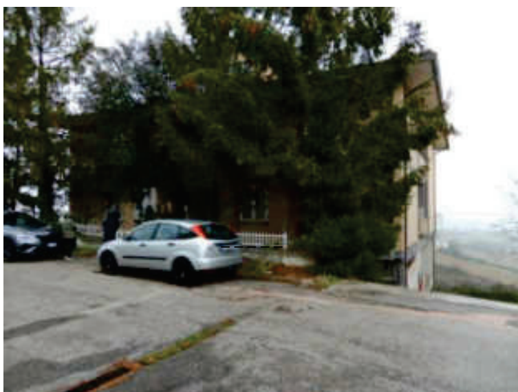
Foto n° 2 – vista spigolo Sud e parete Sud-Ovest – Foto 27.02.2023
