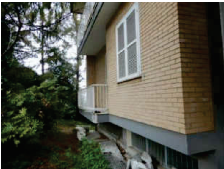
Foto n° 4 – vista spigolo Ovest e parete Sud-Ovest – Foto 27.02.2023
