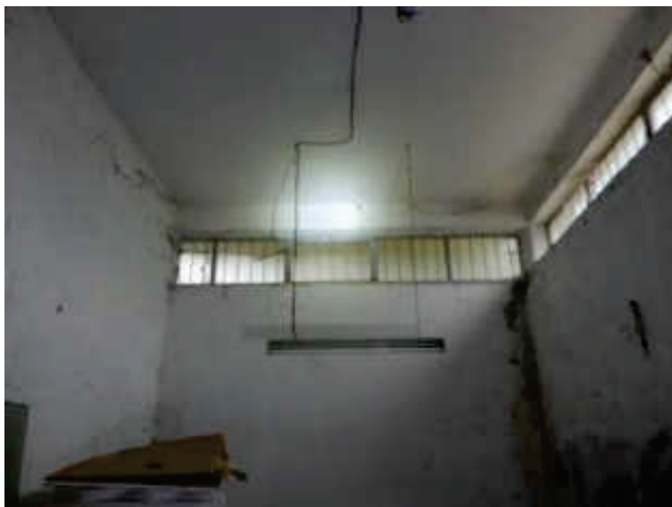
Foto n° 53 – parete Sud-Ovest garage – Foto 27.02.2023
