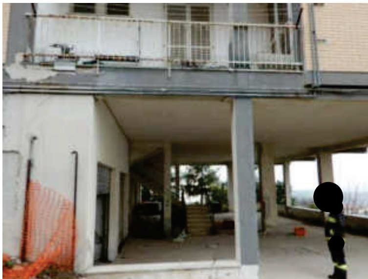
Foto n° 13 – vista spigolo Est piano seminterrato primo – Foto 27.02.2023
