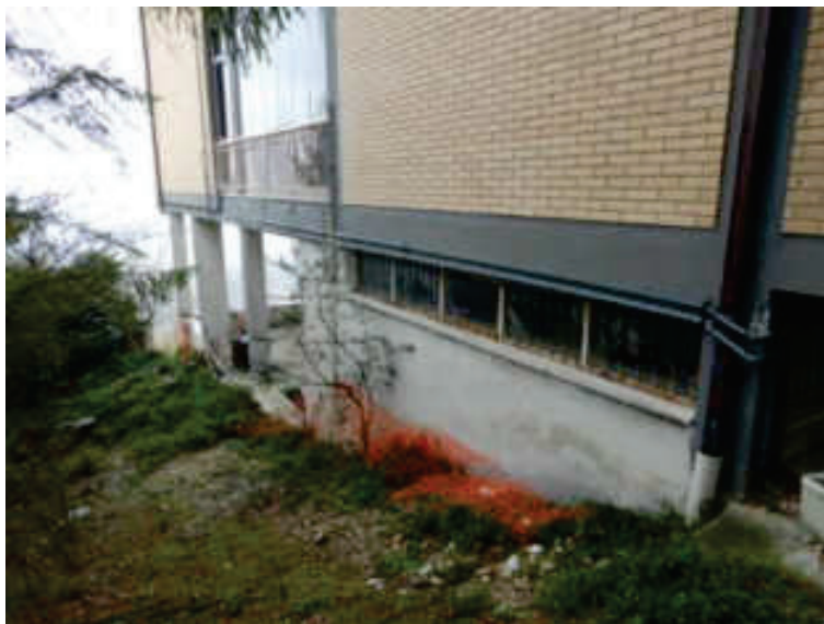
Foto n° 7 – vista spigolo Ovest e parete Nord-Ovest – Foto 27.02.2023
