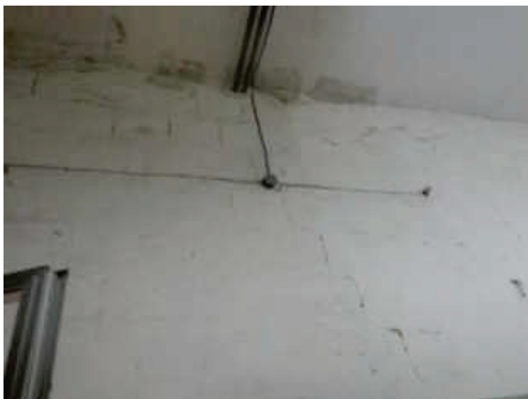
Foto n° 54 – particolare parete divisoria sub. n. 8 e sub. n. 7 – Foto 27.02.2023
