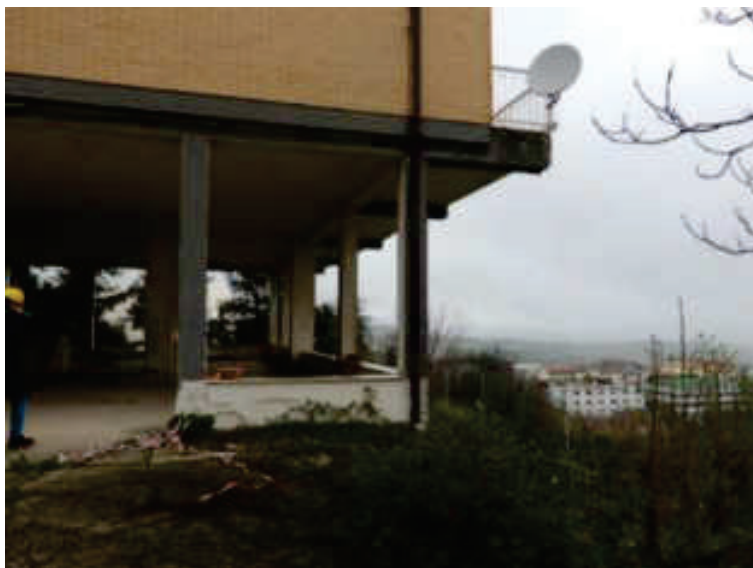
Foto n° 14 – vista spigolo Est piano seminterrato primo – Foto 27.02.2023
