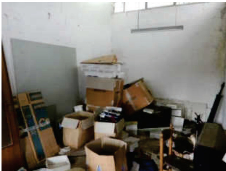
Foto n° 58 – particolare spigolo tra sub. n. 8 e sub. n. 7 – Foto 27.02.2023
