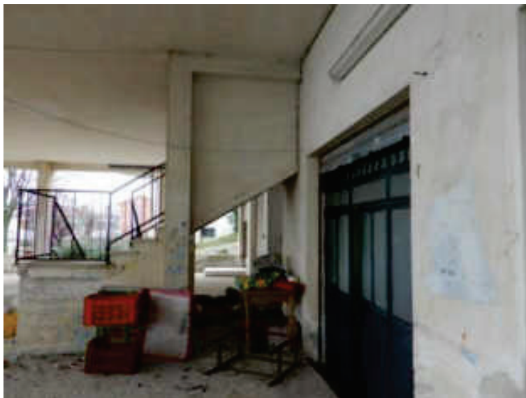
Foto n° 52 – vista da Nord della scala di collegamento condominiale ed ingresso a sub. n. 08 – Foto 27.02.2023
