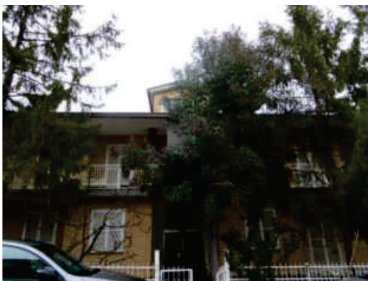
Foto n° 12 – vista complessivo ingresso su parete Sud-Ovest da via Benedetto Croce – Foto 27.02.2023
