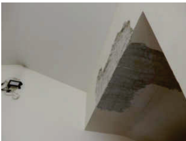
Foto n° 44 – particolare trave in c.a. su disimpegno accesso sub. n. 1 e n. 2 – Foto 27.02.2023
