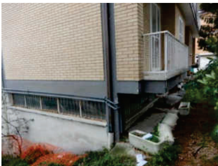
Foto n° 9 – vista spigolo Ovest e pareti Nord-Ovest e Sud-Ovest – Foto 27.02.2023
