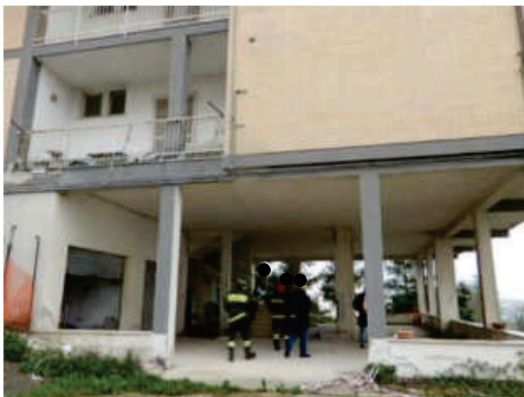
Foto n° 15 – vista parete Sud-Est piano seminterrato primo – Foto 27.02.2023
