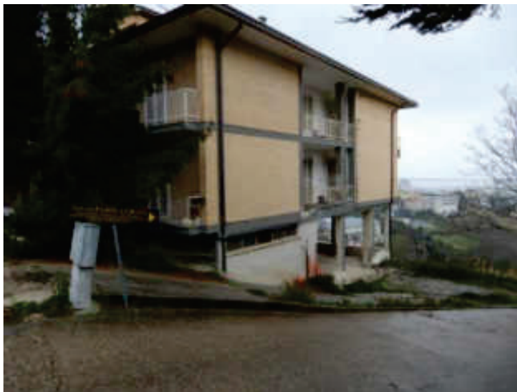
Foto n° 1 – vista spigolo Sud e parete Sud-Est – Foto 27.02.2023
