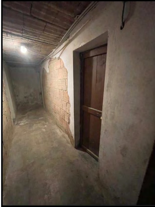
Corridoio alla cantina
