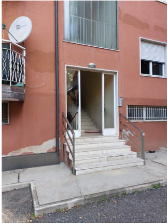
FOTO 3 Vista esterna – Ingresso vano scala
