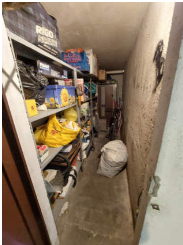
FOTO 11 Vista interna – Cantina
