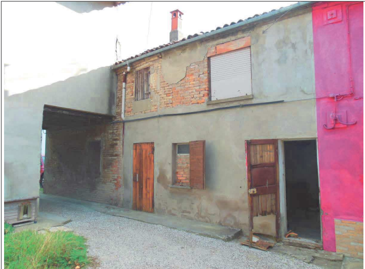
PROSPETTO GENERALE DEL FABBRICATO-MAGAZZINI
