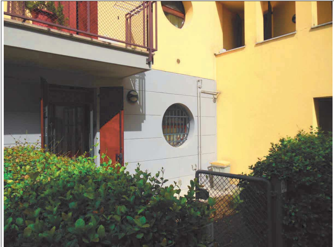
PROSPETTO ANTERIORE ABITAZIONE
