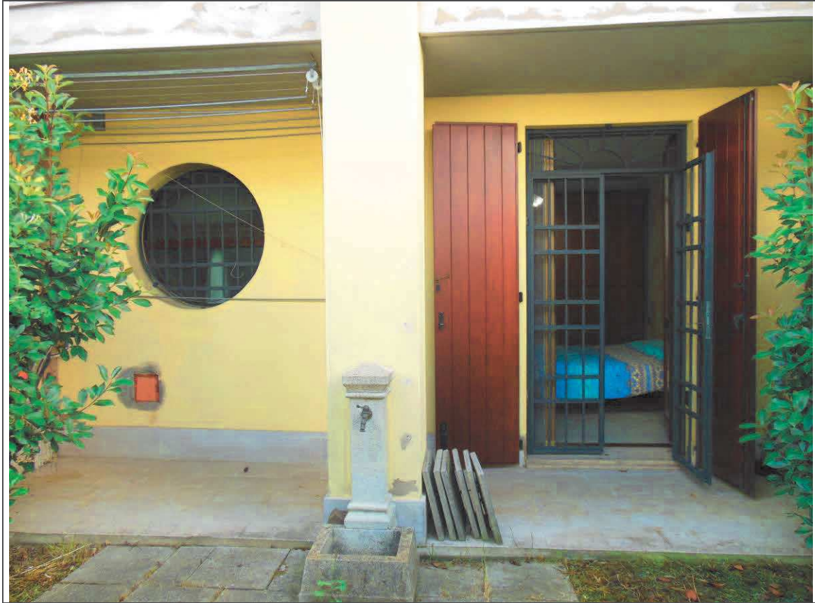
PROSPETTO POSTERIORE ABITAZIONE
