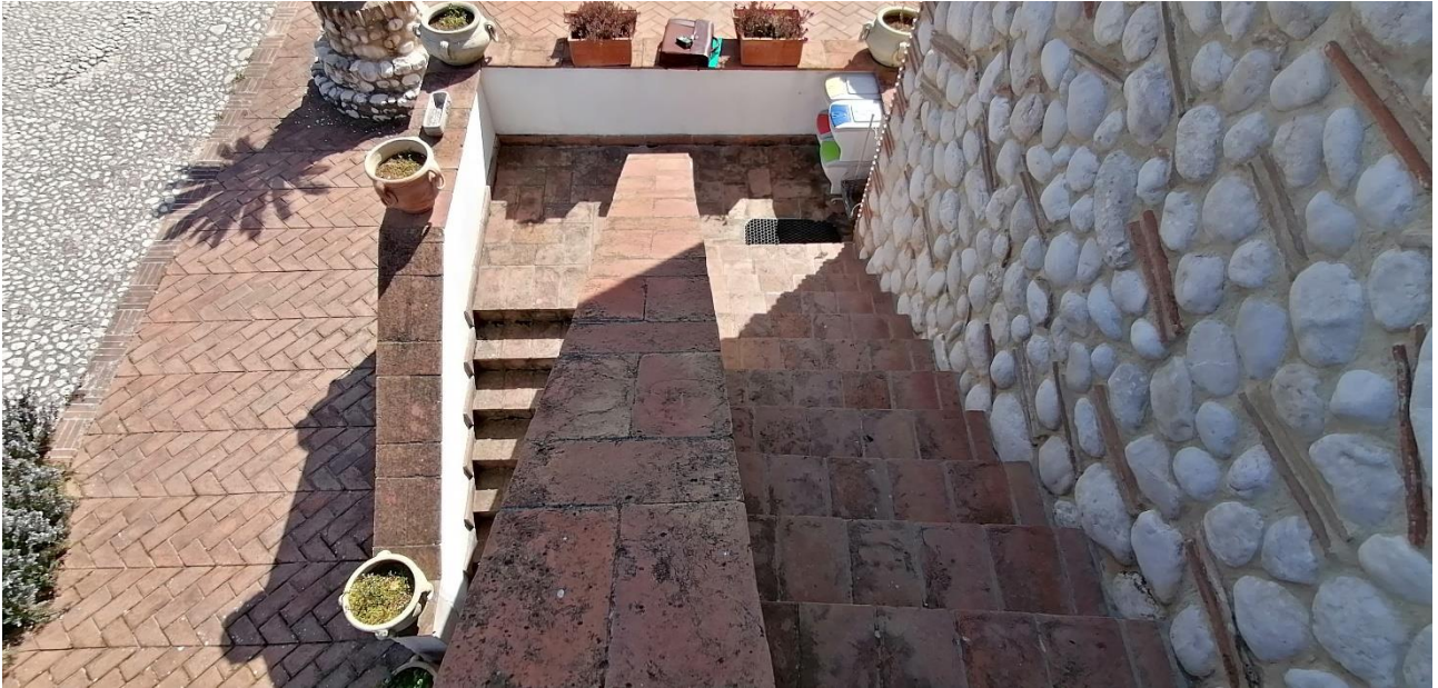
FOTO 2 Scala accesso esterna
