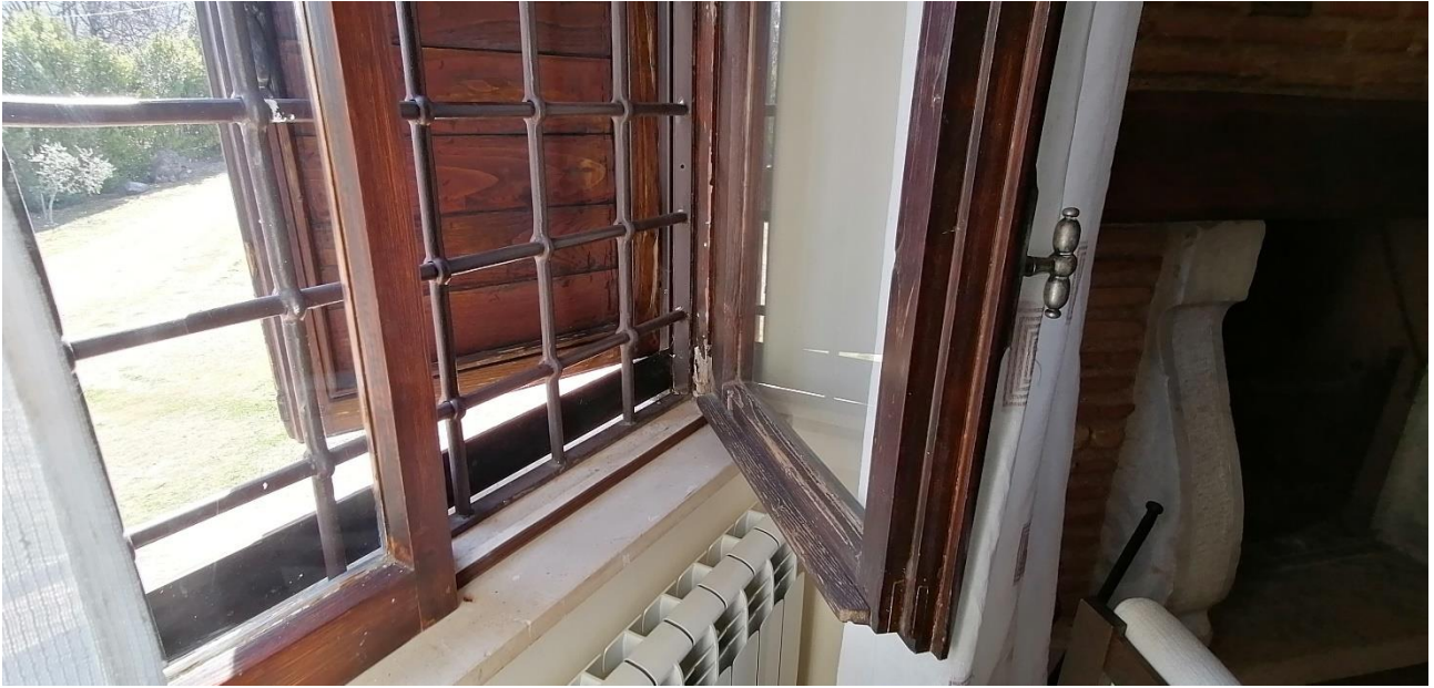
FOTO 14 Particolare infisso esterno
