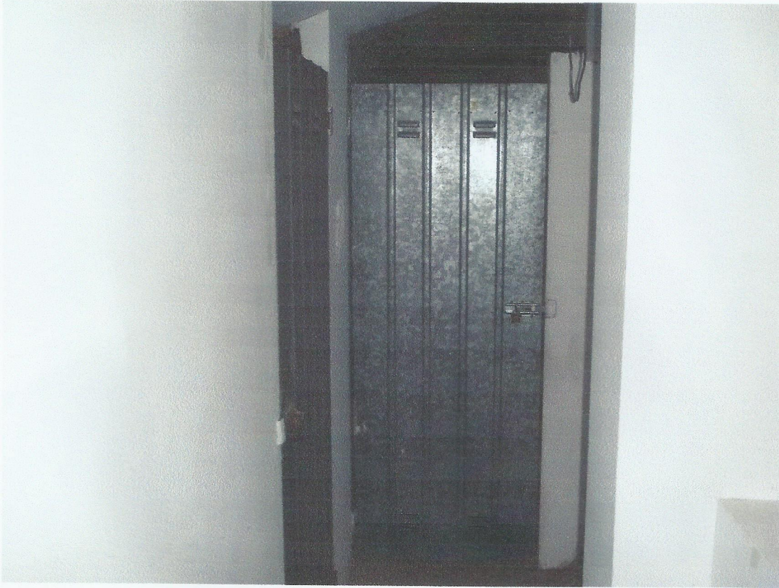
VISTA PORTA DI INGRESSO SOTTOTETTO
