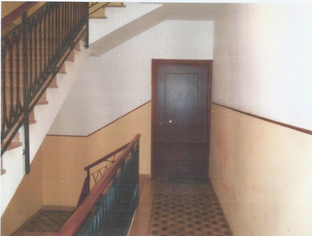
VISTA PIANEROTTOLO INGRESSO UNITA' ABITATIVA
