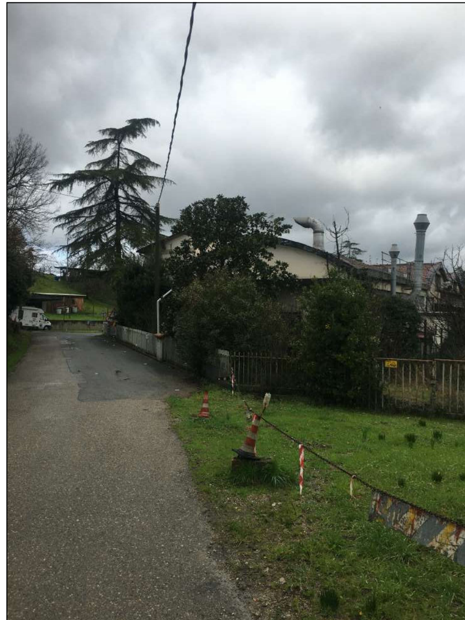
FOTO 8 fabbricato laterale da via Meucci
