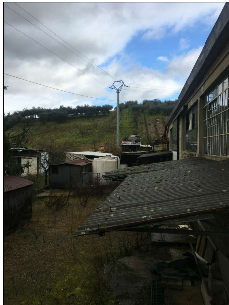
FOTO 14 piazzale interno da via Meucci
