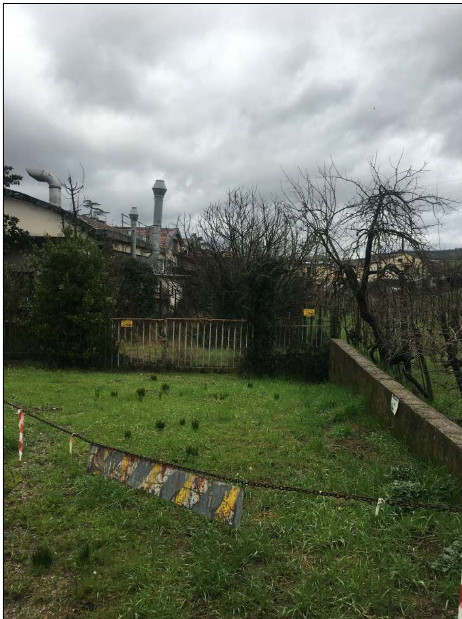
FOTO 9 fabbricato laterale da via Meucci
