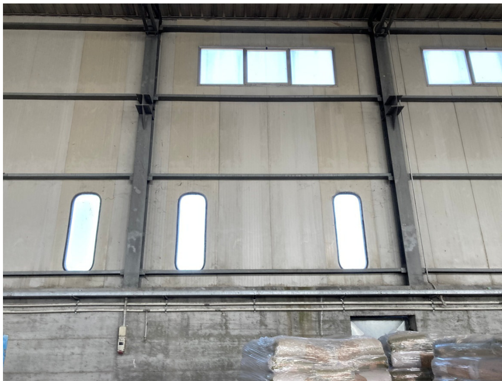
FOTO N° 5 – VISTA INTERNA PROSPETTO
