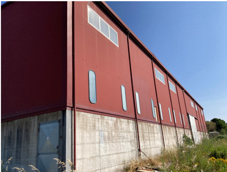
FOTO N° 2 – VISTA PROSPETTO FRONTALE
