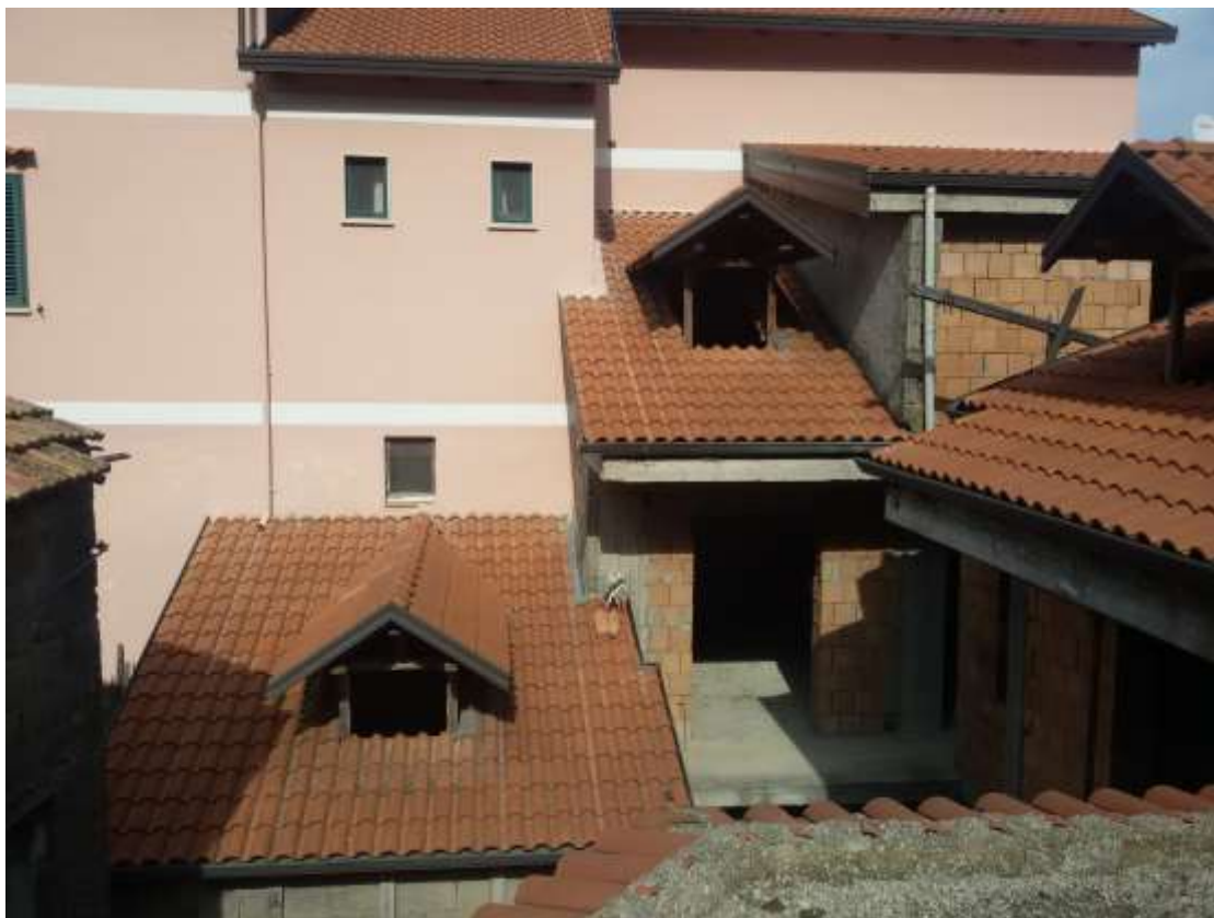
Foto n. 44) Altra vista esterna dei sottotetti
