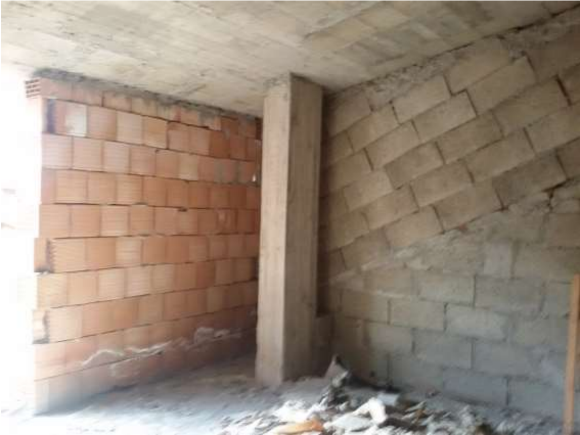
Foto n. 39) Vista d'insieme del Sottotetto 4
