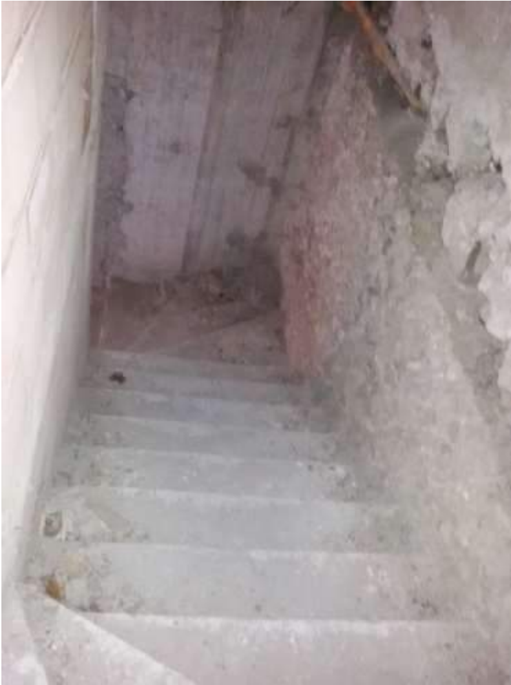
Foto n. 29 Arrivo scala al piano primo dal Locale 5
