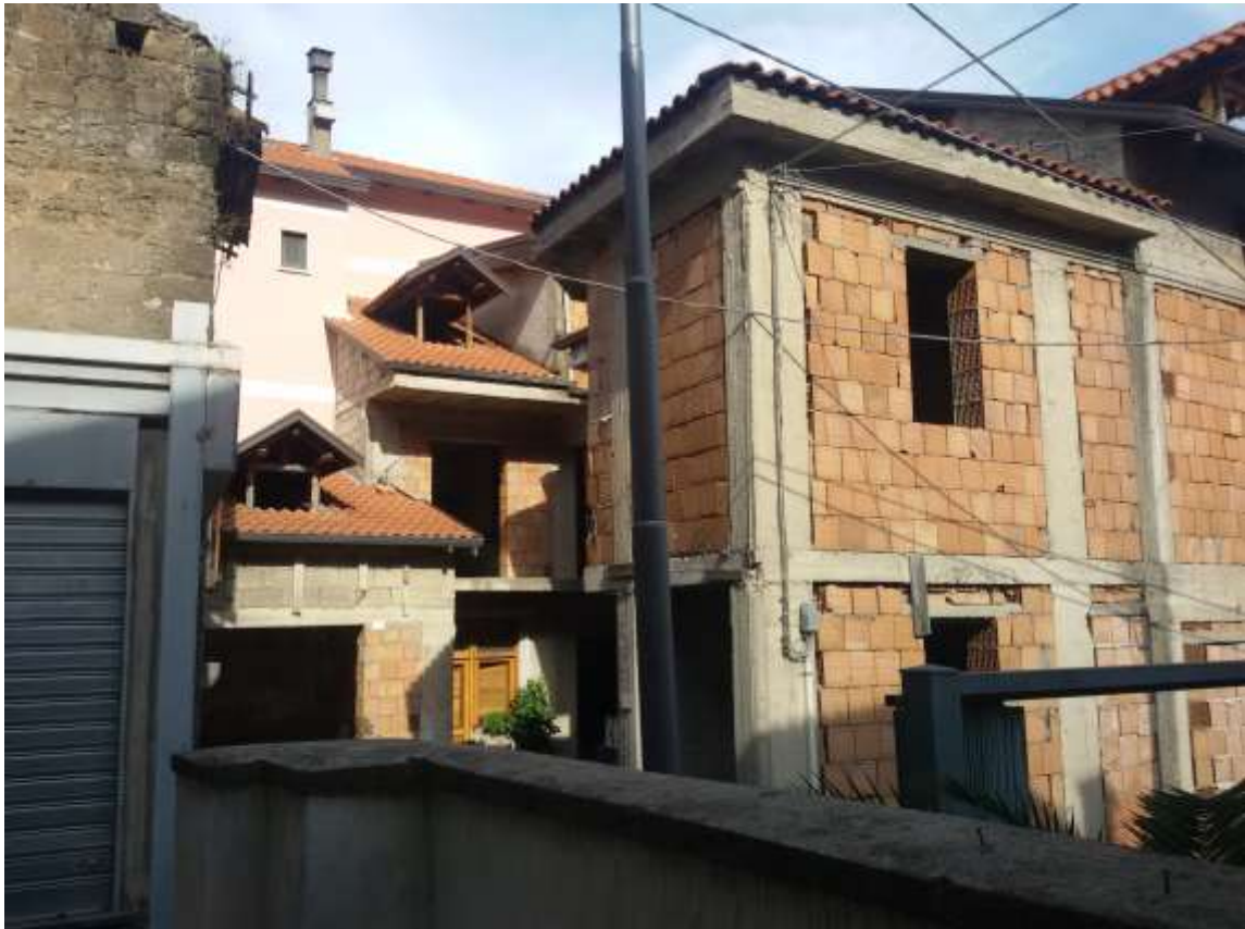
Foto n. 6) Vista d'insieme degli immobili pignorati
