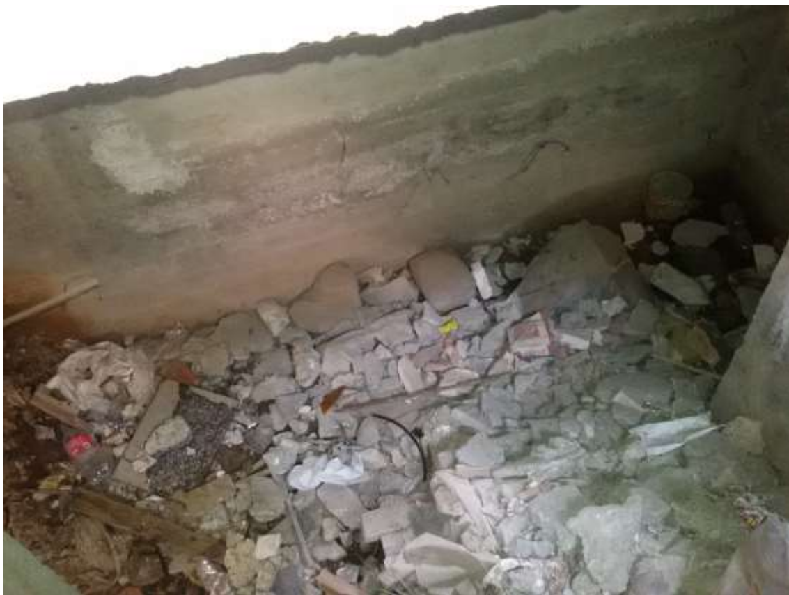
Foto n. 12) Vista d'insieme del Locale 1
