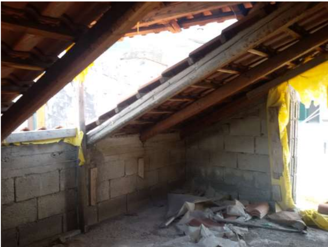
Foto n. 36) Vista d'insieme del Sottotetto 2
