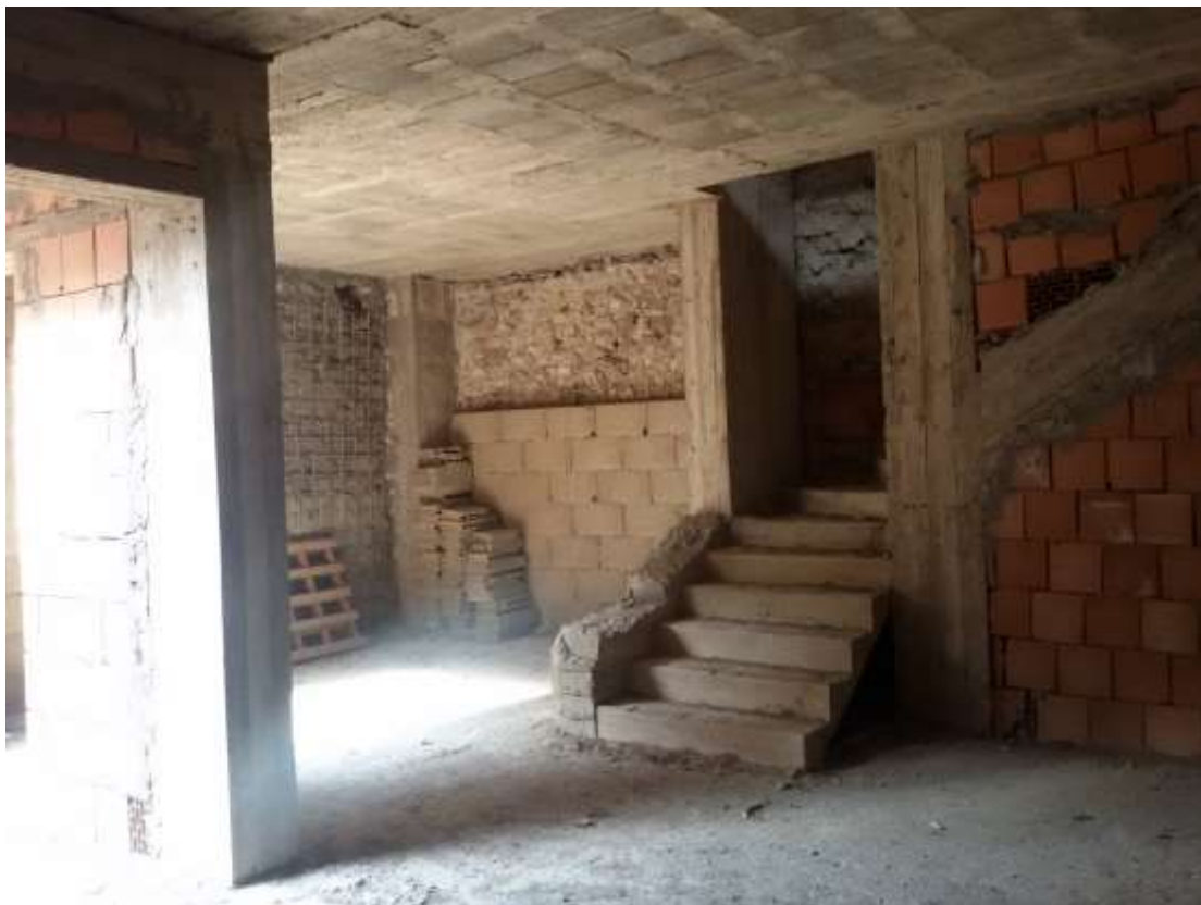
Foto n. 30) Vista d'insieme del Locale 11
