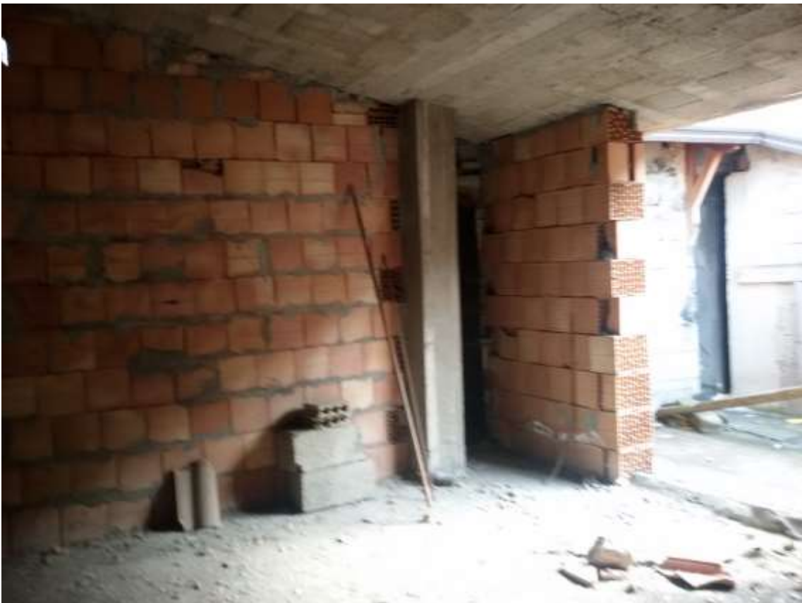
Foto n. 40) Altra vista del Sottotetto 4
