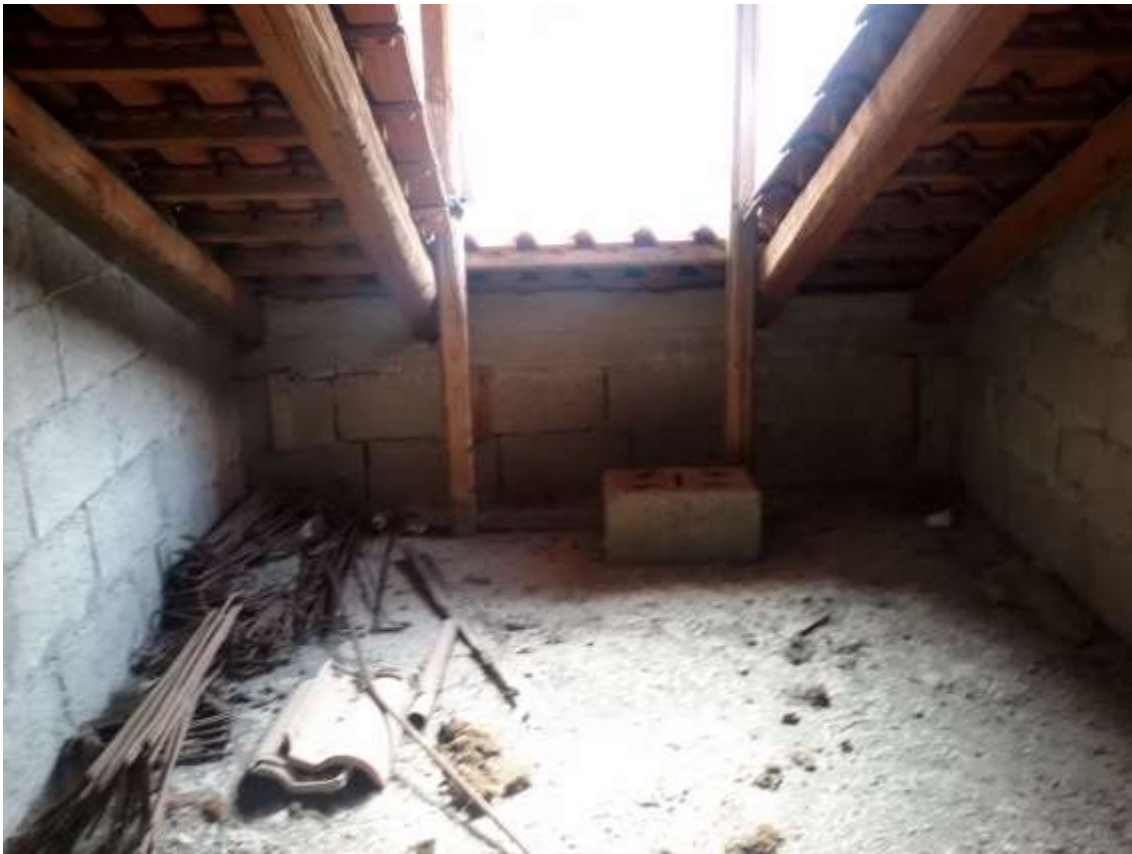
Foto n. 41) Vista d'insieme del Sottotetto 5
