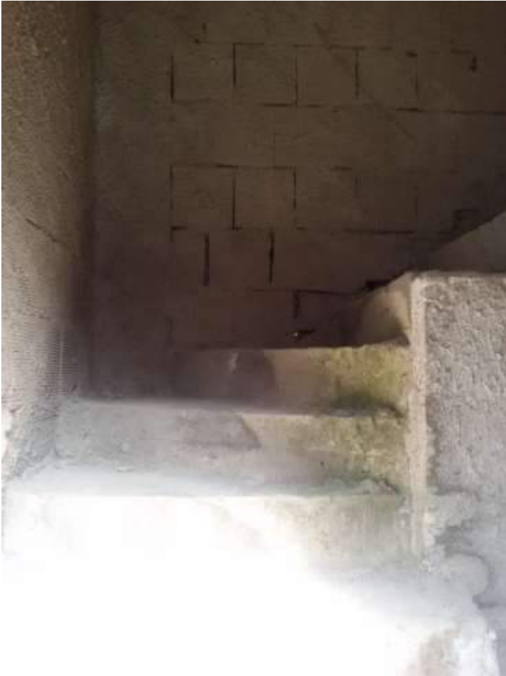
Foto n. 13) Scala che dal Locale 2 conduce al piano primo
