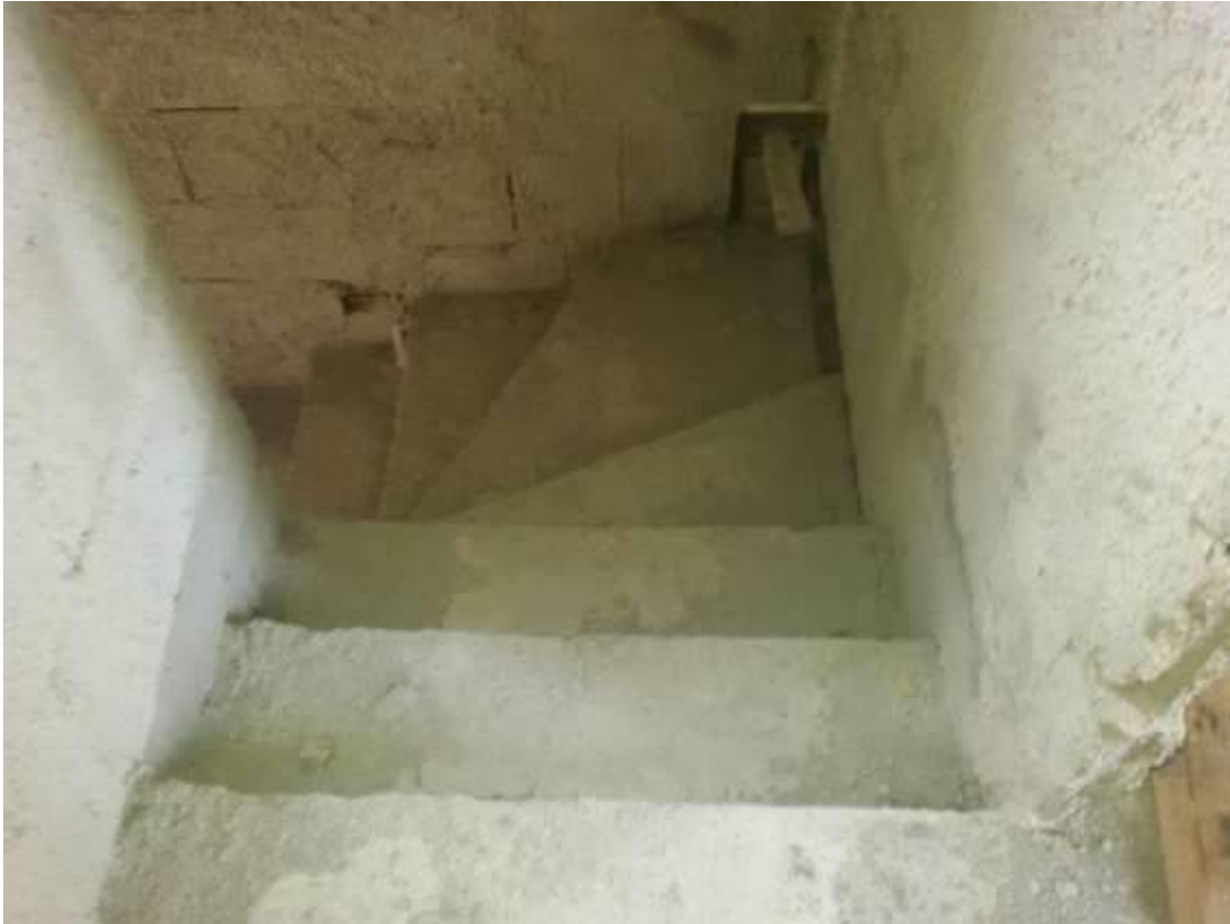
Foto n. 21) Arrivo scala al piano primo dal Locale 2
