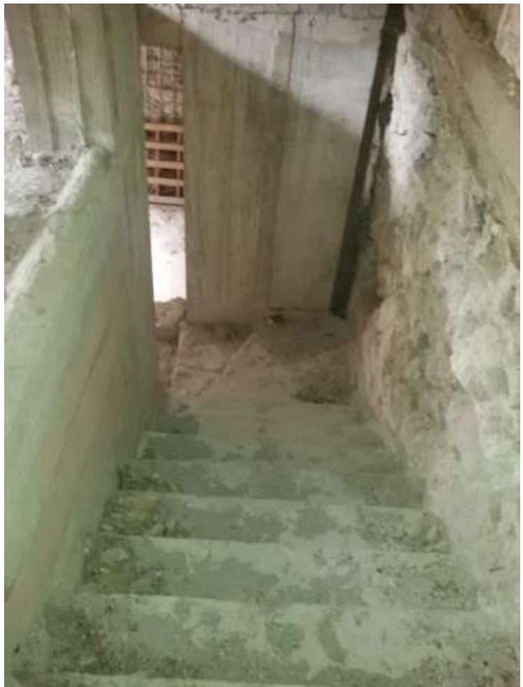
Foto n. 34) Arrivo scala ai sottotetti dal Locale 11
