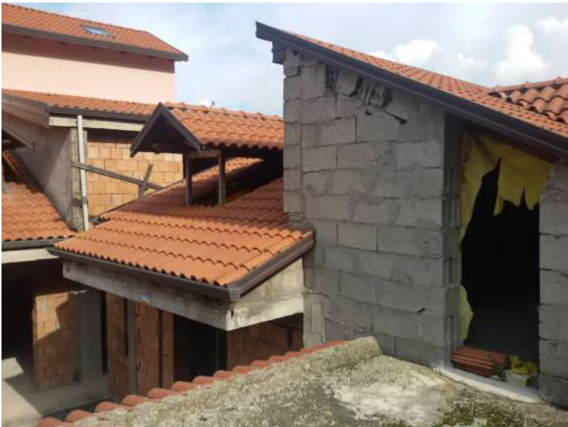
Foto n. 42) Vista esterna dei sottotetti
