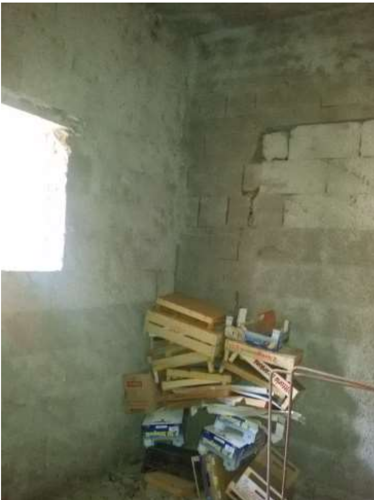
Foto n. 16) Vista d'insieme del Locale 4
