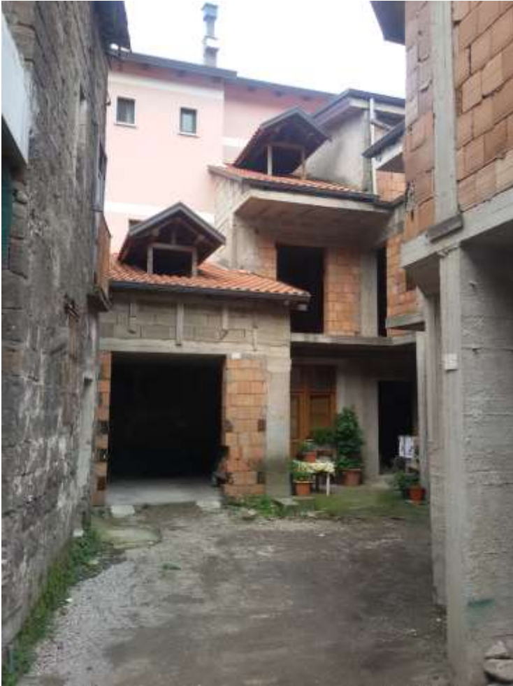
Foto n. 7) Acceso al cortile comune dalla Via Casa Cuomo II
