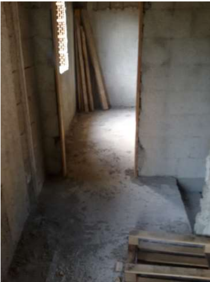
Foto n. 22) Vista d'insieme del Locale 7
