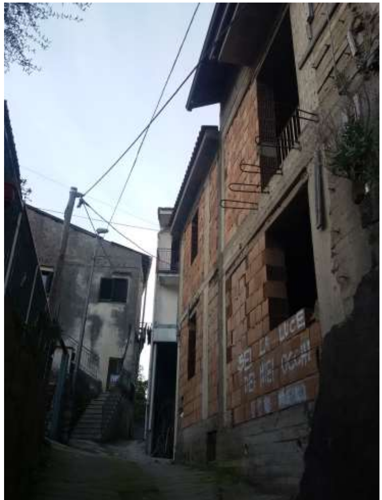
Foto n. 4) Prospetto esterno degli immobili pignorati
