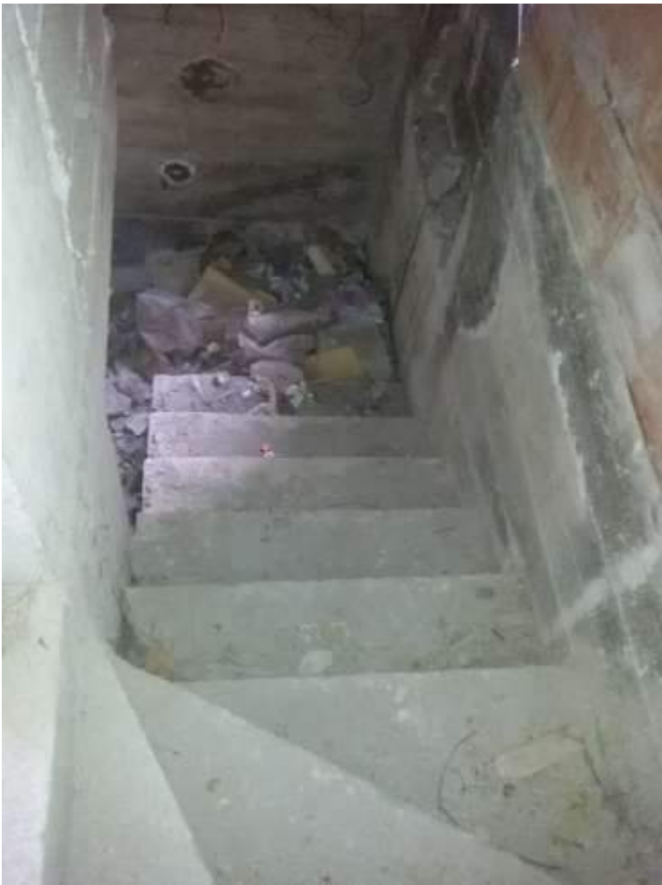
Foto n. 11) Scala che dal Locale 2 conduce al piano cantinato
