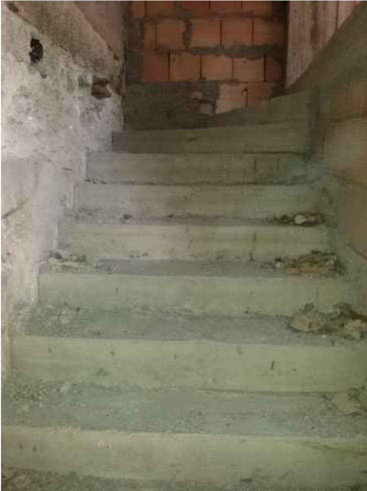
Foto n. 33) Scala che dal Locale 11 conduce ai sottotetti
