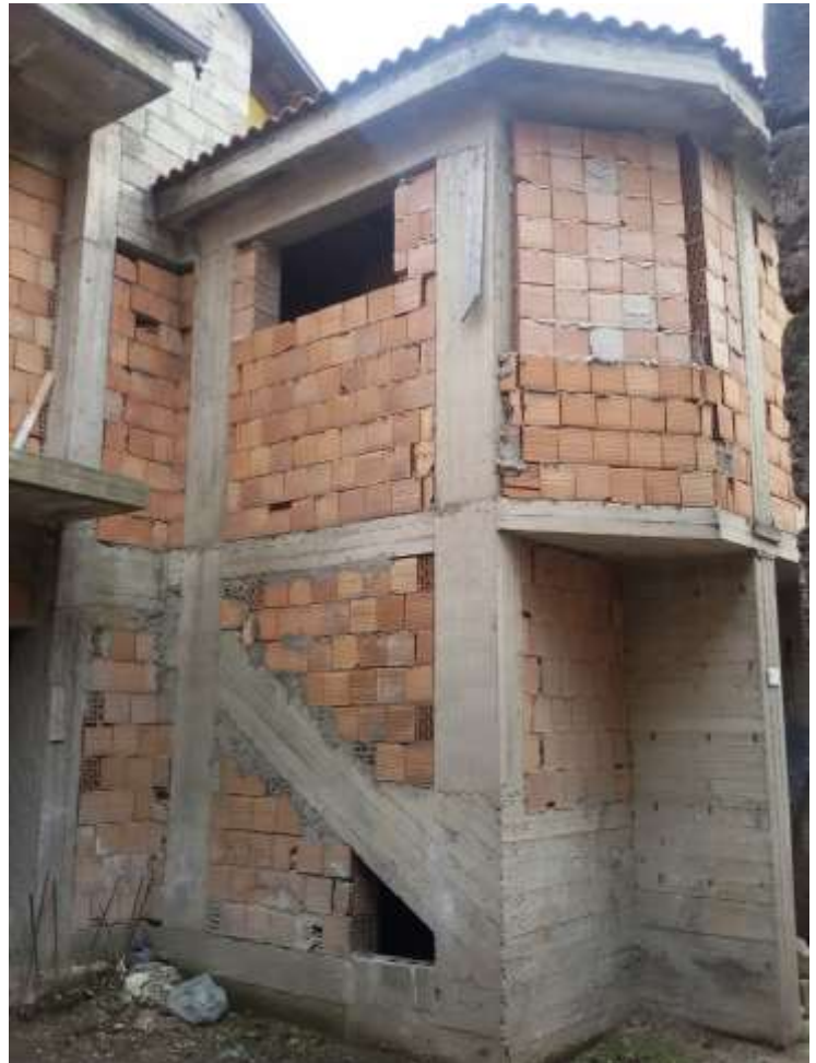
Foto n. 8) Prospetto interno cortile degli immobili pignorati
