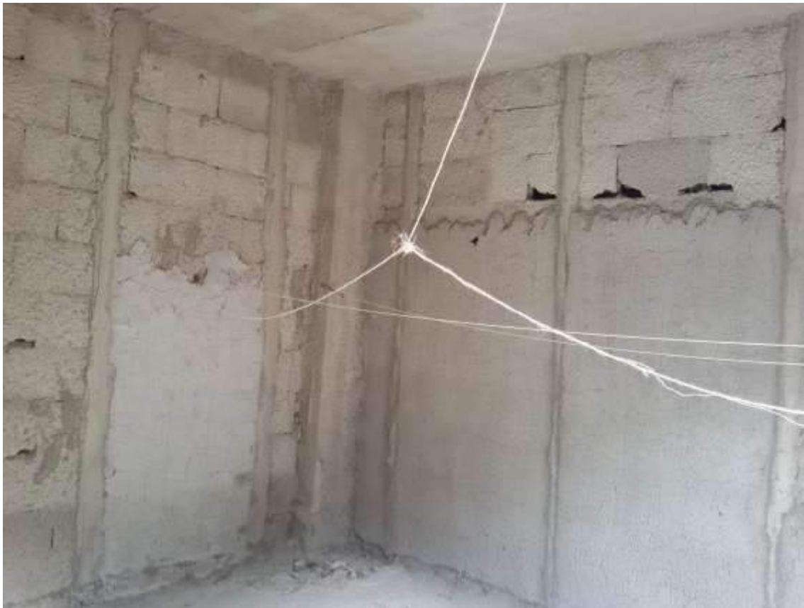
Foto n. 25) Vista d'insieme del Locale 9
