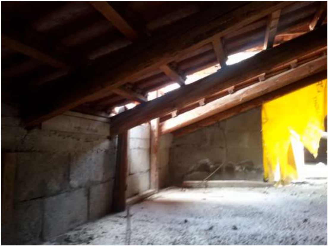
Foto n. 37) Vista d'insieme del Sottotetto 3
