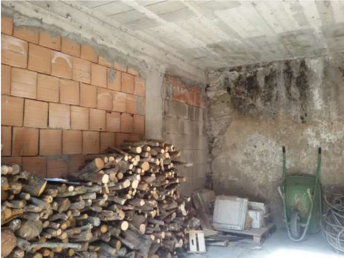
Foto n. 19) Vista d'insieme del Locale 6
