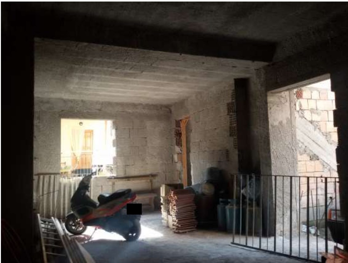
Foto n. 14) Vista d'insieme del Locale 3
