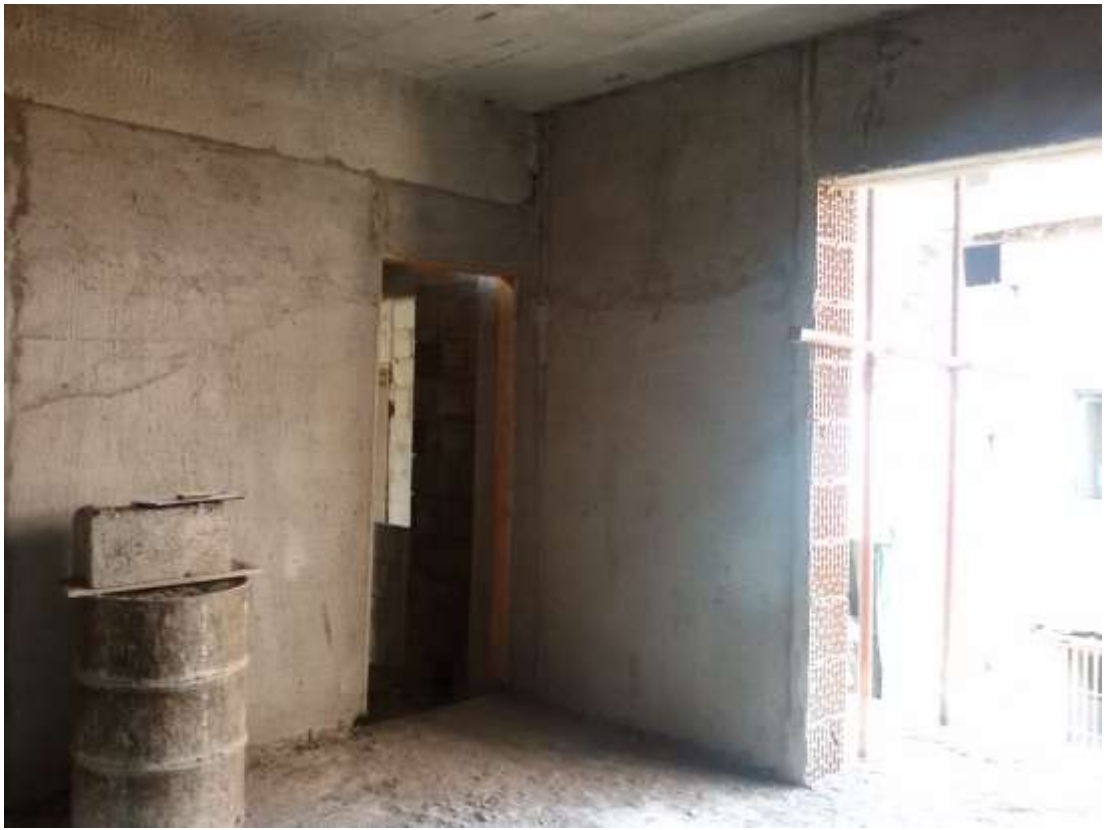
Foto n. 27) Vista d'insieme del Locale 10
