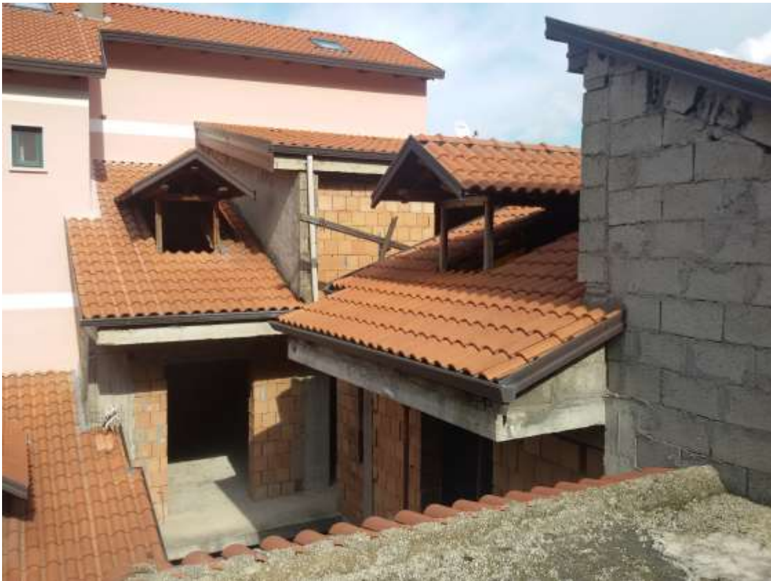
Foto n. 43) Altra vista esterna dei sottotetti
