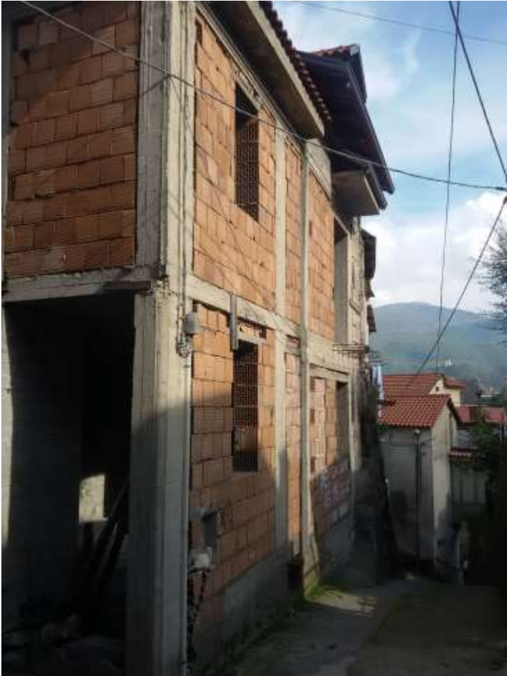
Foto n. 5) Prospetto esterno degli immobili pignorati
