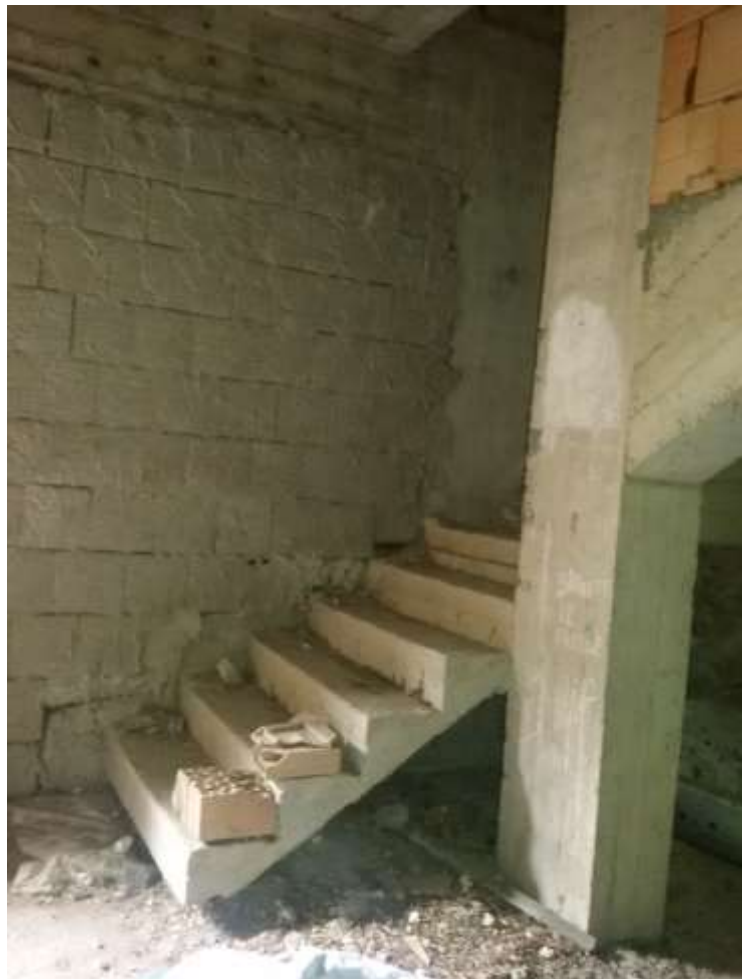
Foto n. 18) Scala che dal Locale 5 conduce al piano primo
