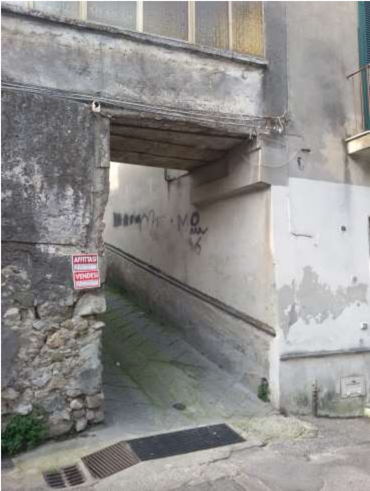
Foto n. 2) Imbocco Via Casa Cuomo II da Via Nuova Tralia
