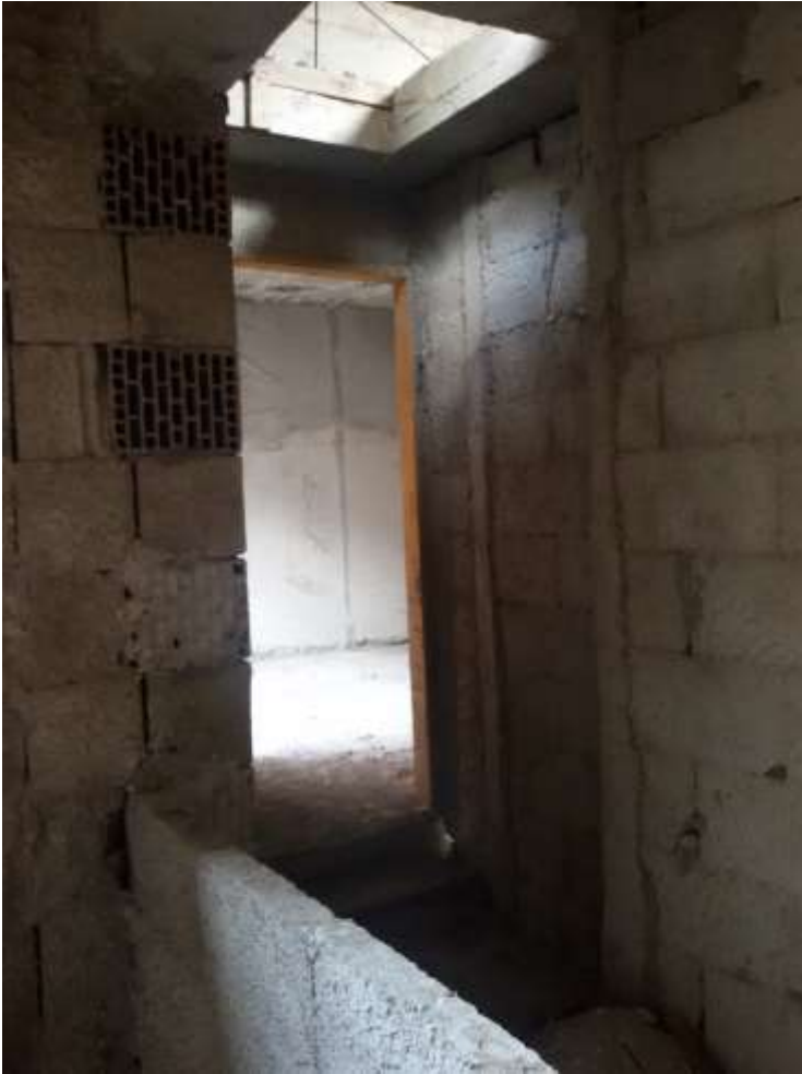
Foto n. 23) Vista d'insieme del Locale 8
