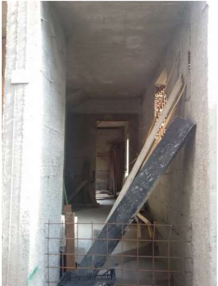
Foto n. 10) Vista d'insieme del locale 2
