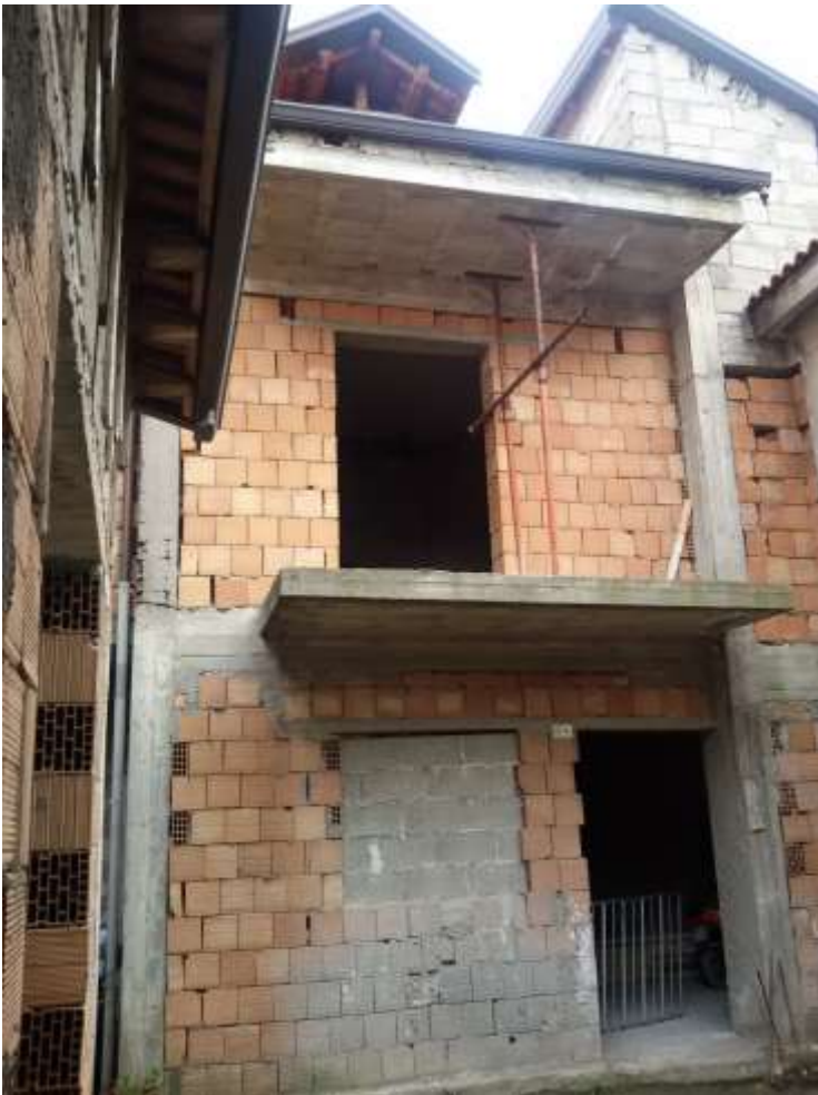
Foto n. 9) Prospetto interno cortile degli immobili pignorati
