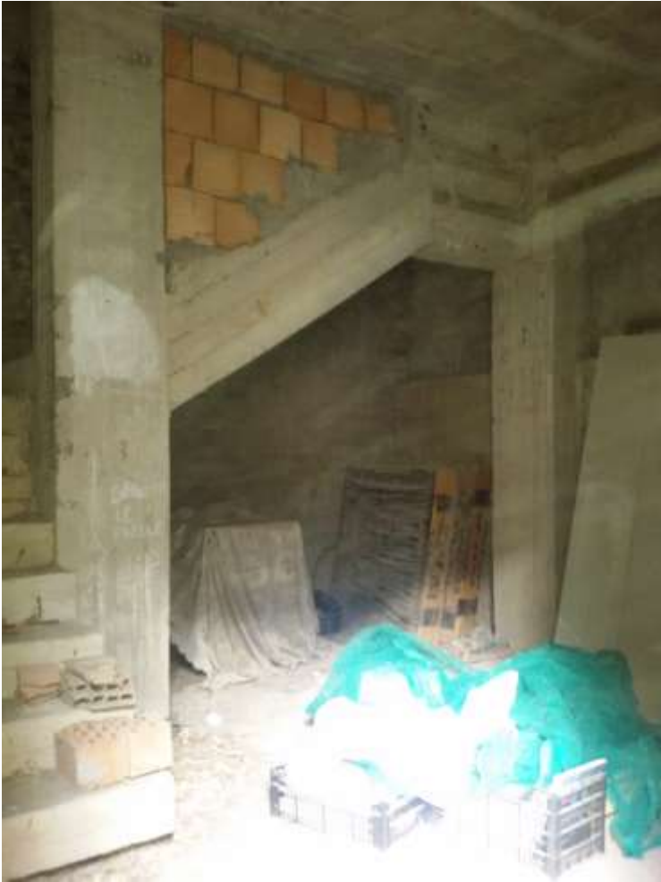
Foto n. 17) Vista d'insieme del Locale 5
