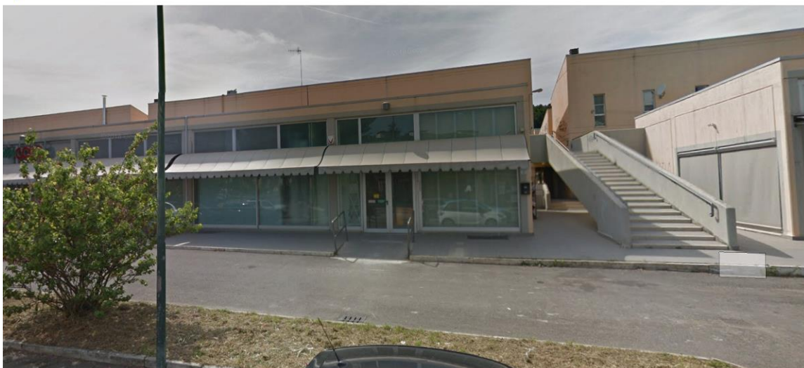
Figura 7 - Vista scala accesso corridoio comune piano primo dal viale Pirandello.
