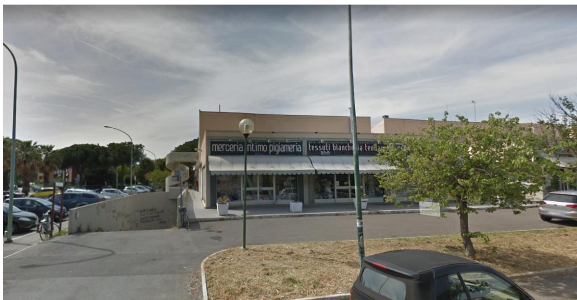
Figura 8 - Vista ingresso rampa carrabile Viale Pirandello.
