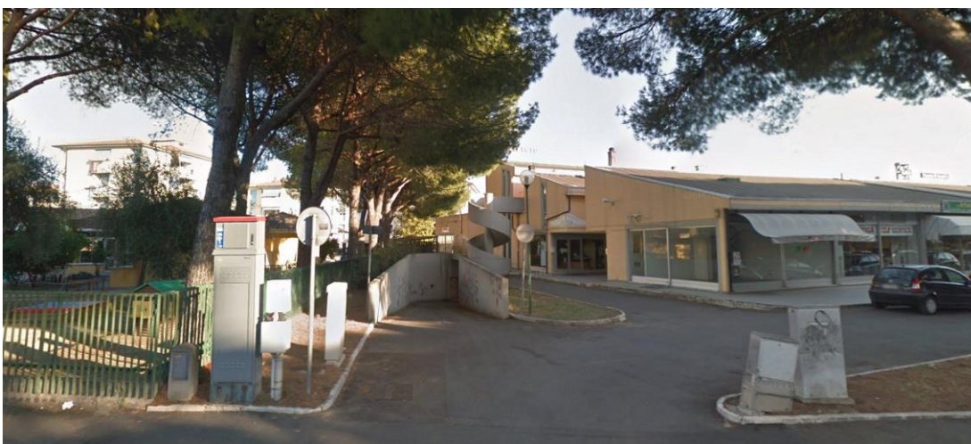
Figura 5 - Vista laterale del fabbricato dall'ingresso rampa carrabile.
