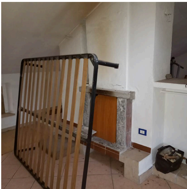
Fotografia n. 16 – Particolare locale sottotetto
