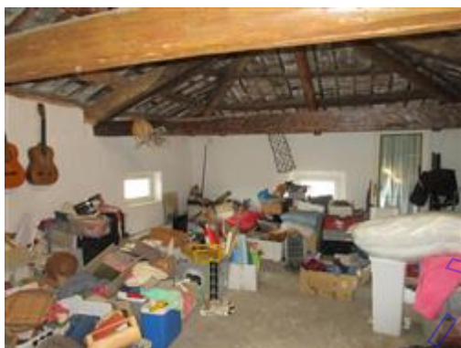
Soffitta al piano sottotetto
