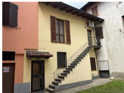
edificio interessato dal pignoramento (appartamento al P.T.)
