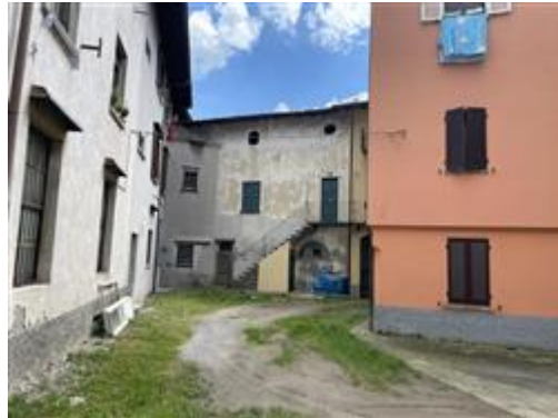
corte interna alla Via Coppola
