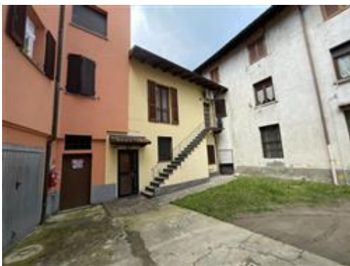
corte interna alla Via Coppola
