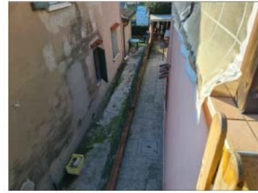
FOTO 15 - VISTA DEL CONFINE LATERALE DALL'ALTO
