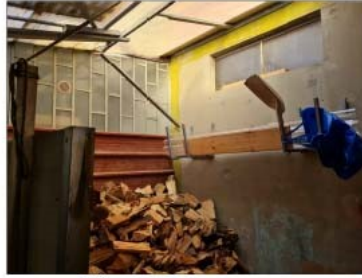
FOTO 32 - AUTORIMESSA A PIANO TERRA
