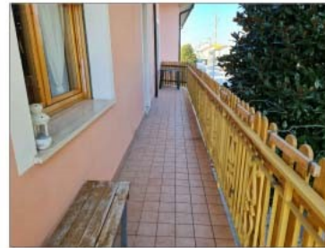
FOTO 29 - BALCONE SUL FRONTE PRINCIPALE
