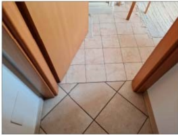
FOTO 58 - PIANO PRIMO DETTAGLIO PAVIMENTAZIONI
