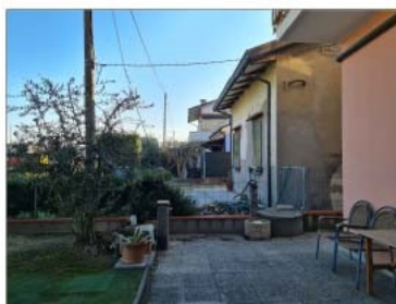
FOTO 23 - VISTA DEL CORTILE E DEL GIARDINO SU VIA CAPANNAGUZZO
