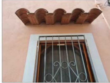
FOTO 65 - FINESTRA A PIANO TERRA CON GRATA ANTI-INTRUSIONE
