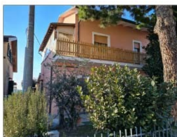
FOTO 08 - PROSPETTO LATERALE E VISTA VERANDA NON CONFORME
