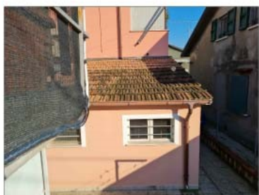
FOTO 19 - VISTA AMPLIAMENTO A PIANO TERRA NON CONFORME
