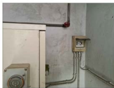
FOTO 72 - CALDAIA PIANO TERRA
