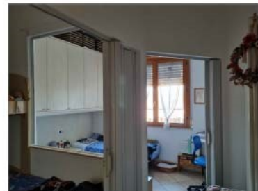
FOTO 54 - PIANO PRIMO CAMERA CON SUDDIVISIONE NON CONFORME
