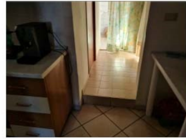
FOTO 39 - PIANO TERRA VANO W.C.
