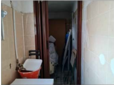
FOTO 34 - VANI NEL FABBRICATO STACCATO A SERVIZI
