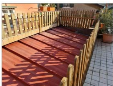
FOTO 25 - COPERTURE TETTOIE A PIANO TERRA NON CONFORMI
