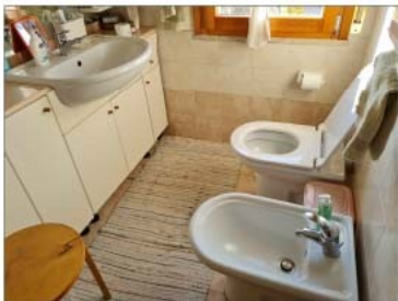
FOTO 52 - PIANO PRIMO BAGNO PRINCIPALE
