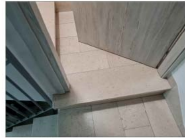
FOTO 60 - VANO SCALA DETTAGLIO INGRESSO PIANO PRIMO
